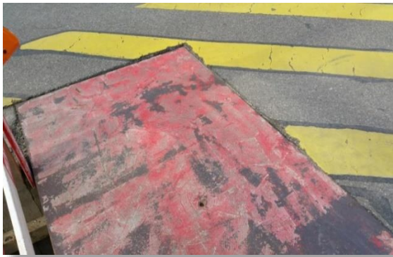
Versenkte Stahlplatte in Fahrbahn
