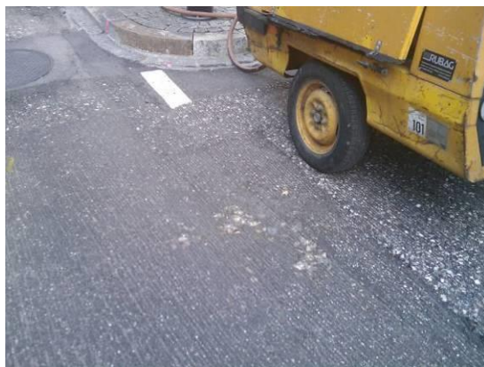
Tragschicht zu dünn eingebaut (nach Fräsarbeiten von 3 cm erkannt)
