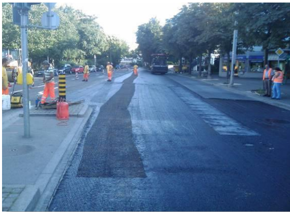
Verlegtes Carbophalt-Netz
