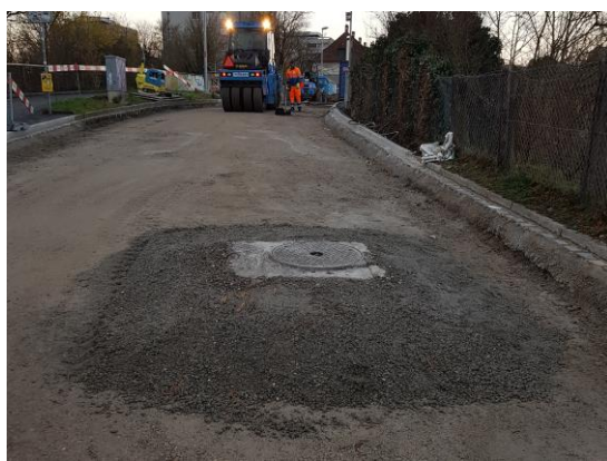
Unzulässige Schachtumhüllung mit Beton
