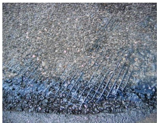
Stressabsorbing Mastix Inlay (SAMI) spannungsabsorbierende Membrane
