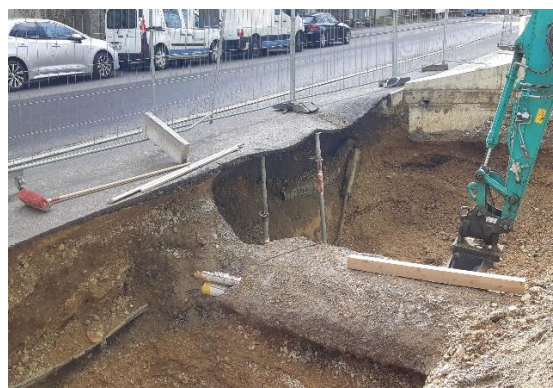
Fehlende Spriessung (2.5 m Tiefe) Baugrube
