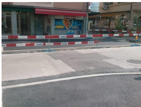
Tragschicht: Flick an Flick im Kreuzungsbereich
