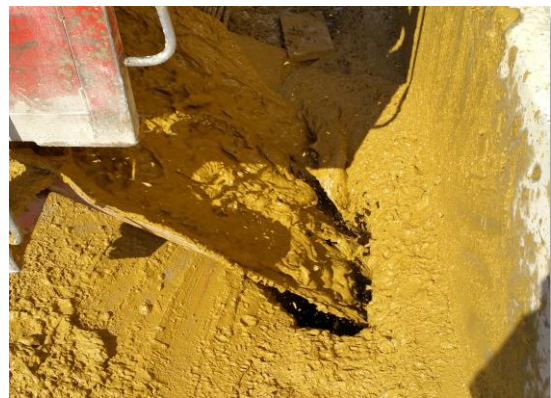
Verfüllen von unerwünschten Hohlräumen (Rühlwand)
