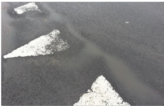
Übermässiger Abrieb in 3-jährigem Testbelag
