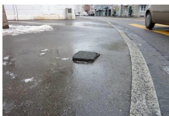
Frosthebung (keine Frostsicherheit)
