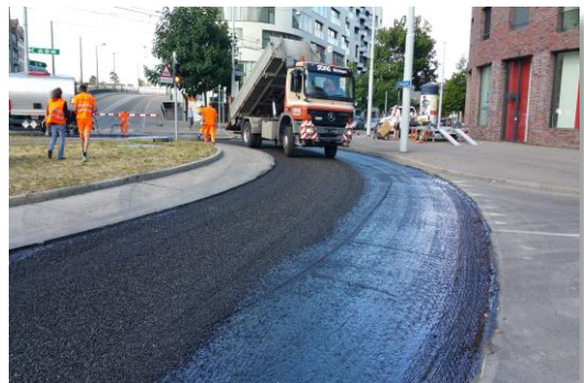
SAMI mit vorumhülltem Splitt wird eingebracht
