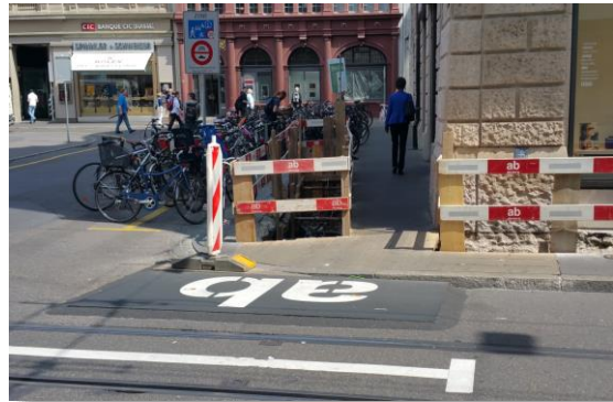
Versenkte Holzdielen mit angeramppter Stahlplatte
