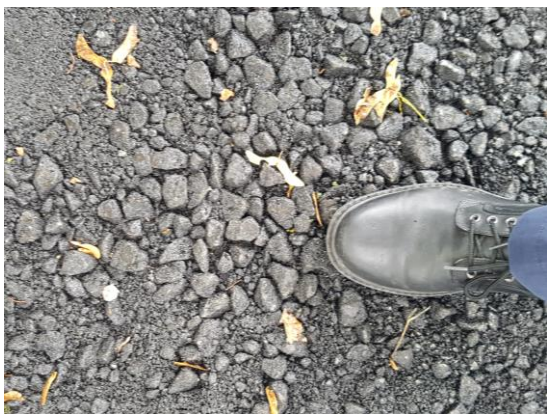
Entmischte "definitiv" eingebaute Tragschicht
