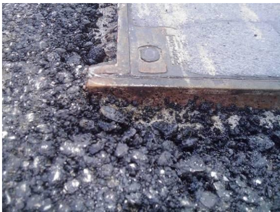
Tragschicht zu hoch gebaut
