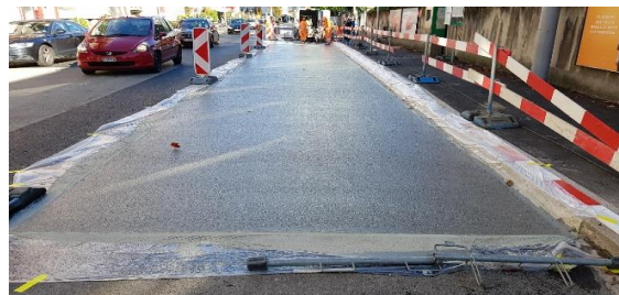
Frisch eingebauter VB11 (hier das Produkt CONFALT)
