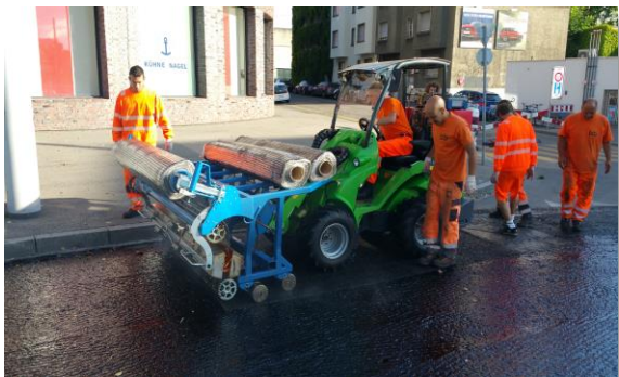
Carbophalt-Netz wird in einem Kreisel verlegt
