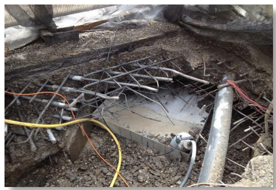
Durchtrennen statischer Brückenbewehrung
