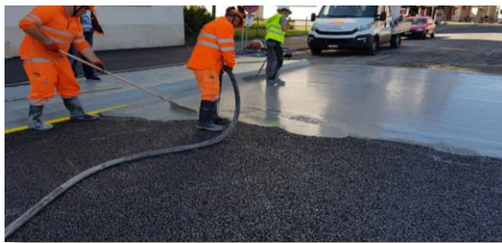
Verfüllen des bituminösen Belags mit der Schlämme
