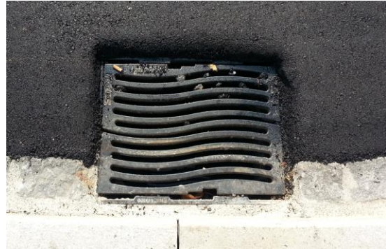
Zu tief eingebauter Einlaufrost
