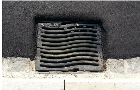
Zu tief eingebauter Einlaufrost
