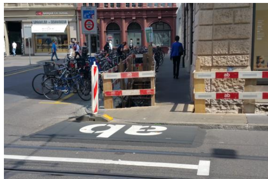
Versenkte Holzdielen mit angerampter Stahlplatte
