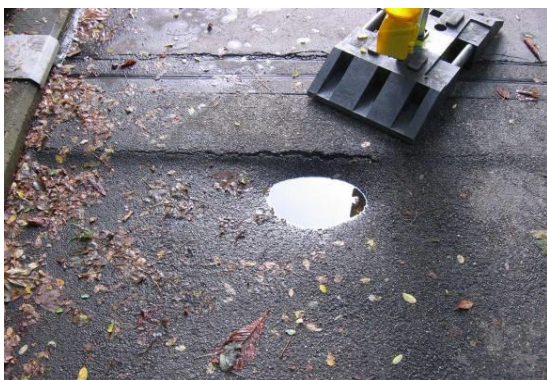
Senkung (ungenügende Verdichtung)
