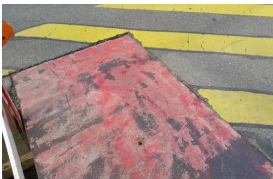
Versenkte Stahlplatte in Fahrbahn
