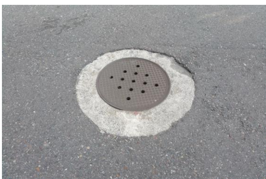
Beton statt Belag (Blick auf Binderschicht)
