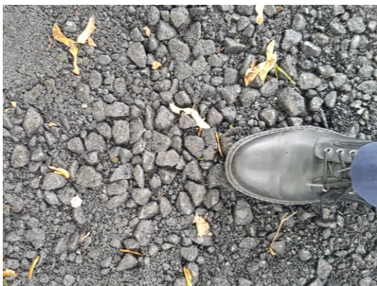
Entmischte "definitiv" eingebaute Tragschicht
