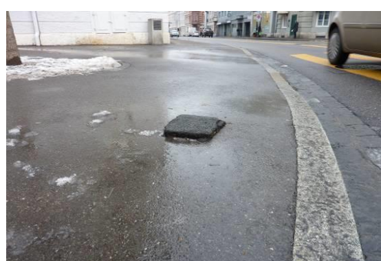
Frosthebung (keine Frostsicherheit)
