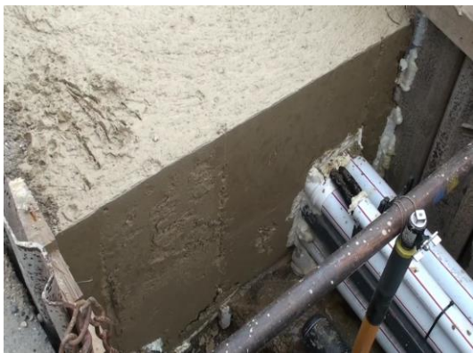
Flüssigboden nach Ausbau des Schotts
