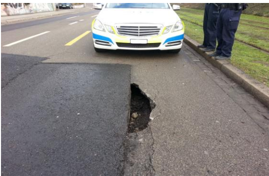
Einbruch bei Bauprovisorium
