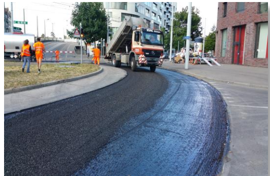
SAMI mit vorumhülltem Split wird eingebracht
