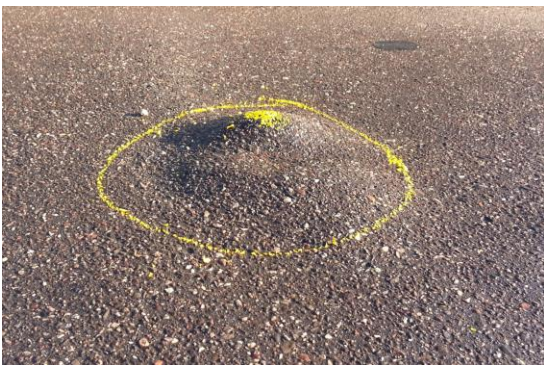
Dampfblase unter Gussasphalt ("Warze")
