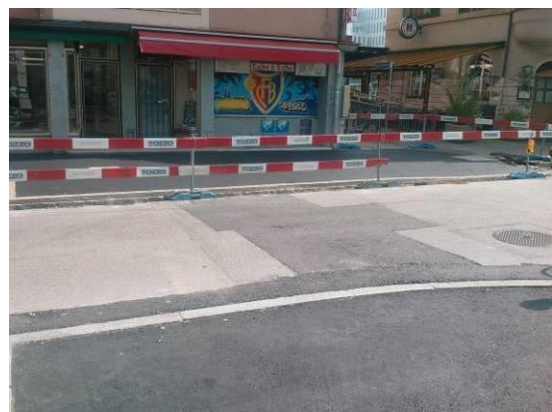
Tragschicht: Flick an Flick im Kreuzungsbereich
