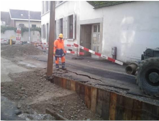
Werkleitungsgräben: Spriessung zu spät gezogen
