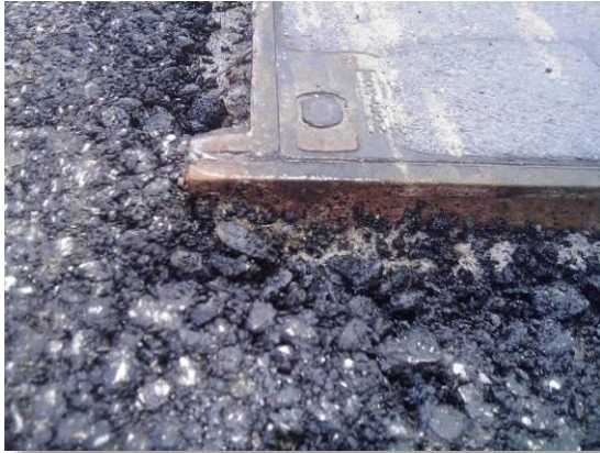
Tragschicht zu hoch gebaut
