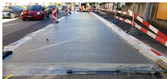
Frisch eingebauter VB11 (hier das Produkt CONFALT)
