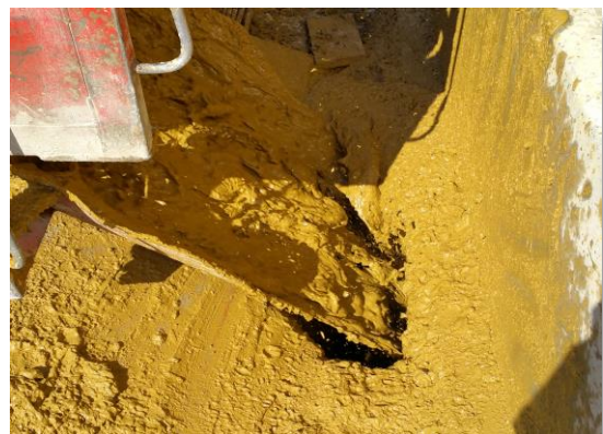
Verfüllen von unerwünschten Hohlräumen (Rühlwand)
