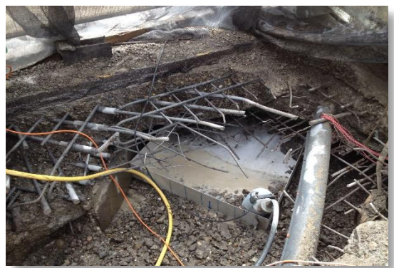
Durchtrennen statischer Brückenbewehrung
