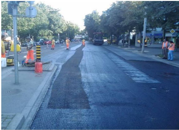
Verlegtes Carbophalt-Netz
