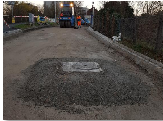
Unzulässige Schachtumhüllung mit Beton
