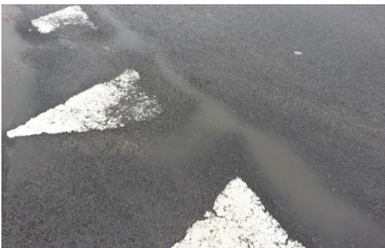
Übermässiger Abrieb in 3-jährigem Testbelag
