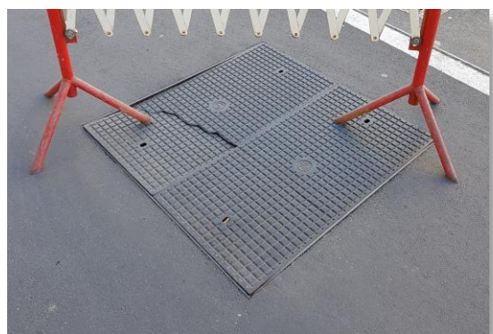
Falsche Lastklasse der Abdeckung in einer Fahrbahn
