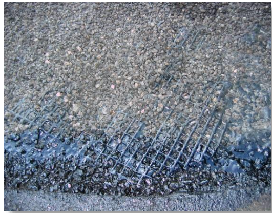
Stressabsorbing Mastix Inlay (SAMI) spannungsabsorbierende Membrane
