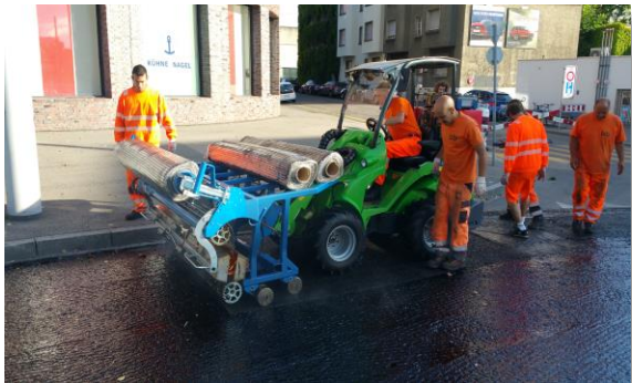
Carbophalt-Netz wird in einem Kreisel verlegt
