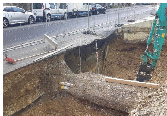
Fehlende Spriessung (2.5 m Tiefe) Baugrube
