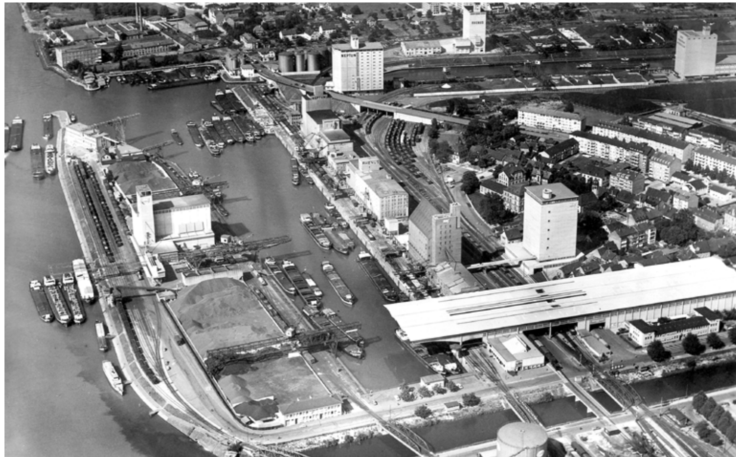
Der Rheinhafen Basel-Kleinhüningen gegen Ende der 1960er Jahre. Noch sind grosse Kohleberge am Westquai und entlang des Hafenbeckens II aufgehäuft. Gut ersichtlich sind die beeindruckenden Dimensionen des 1952/53 errichteten Umschlaghofs.
