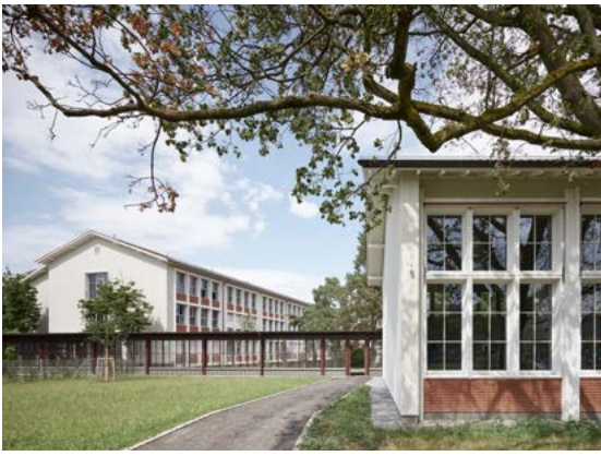
Schulanlage mit Turnhalle im Vordergrund
