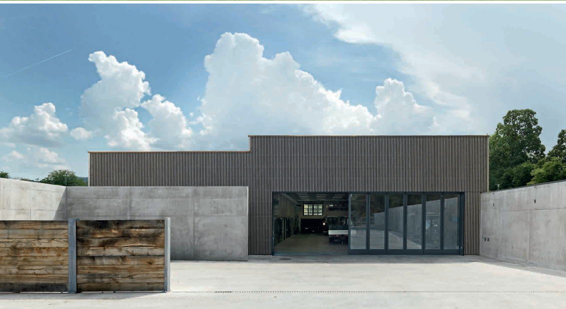
Zufahrt zur Fahrzeughalle, Sandlager
