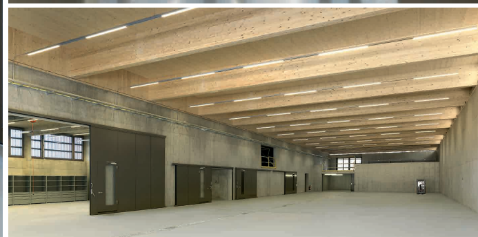
Sicht innen/ausen, Gemeinschaftsbereich Personal Fahrzeughalle
