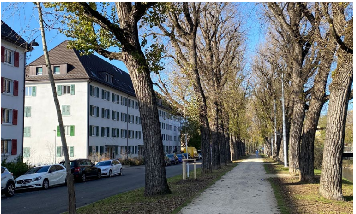
Fussweg auf der Dammkrone (linkes Ufer) heute. Die Liegenschaften wurden im Jahr 1927 erbaut. Foto: G. Köhler
