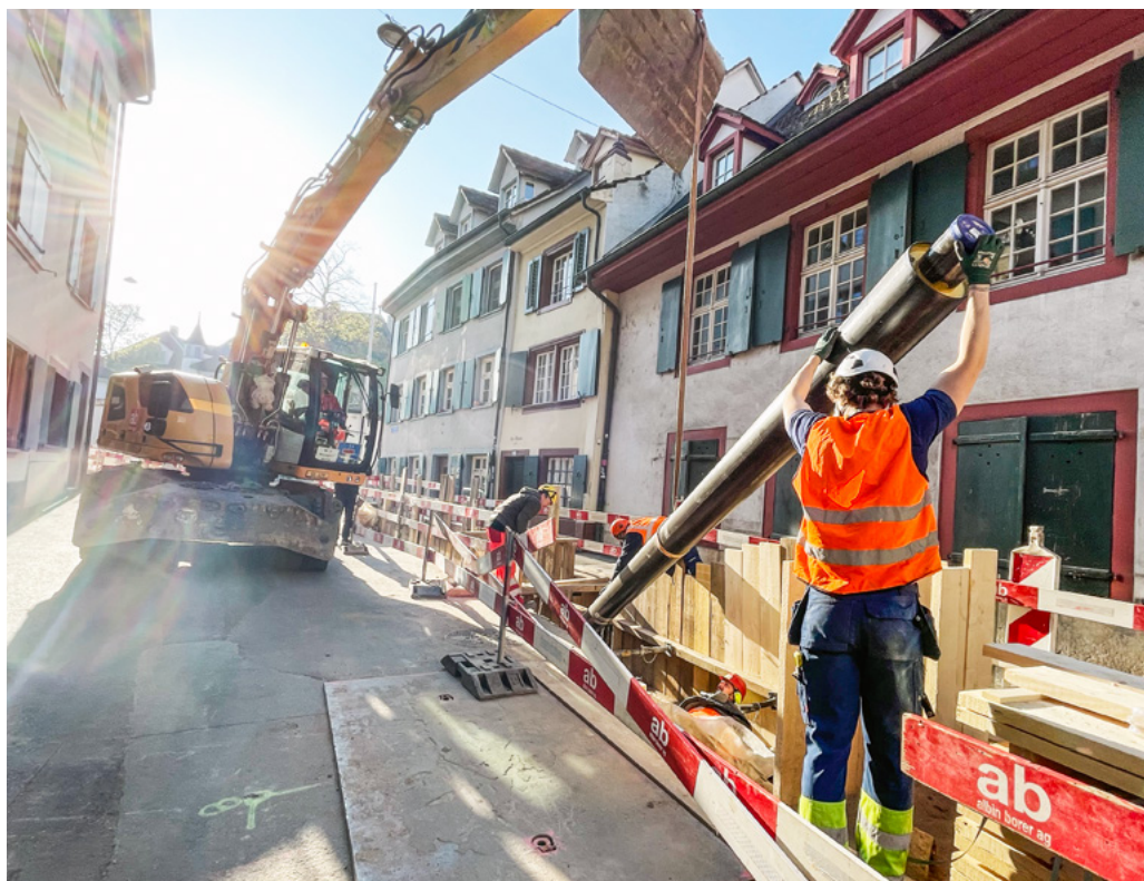
Verlegung der Fernwärmerohre im Bereich der Rheingasse.
