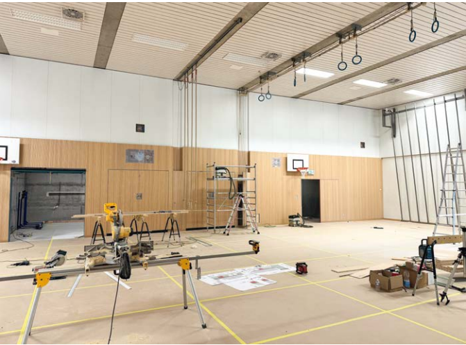
Die Turnhalle während der Sanierungsarbeiten, Foto: Daniel Schmitt
