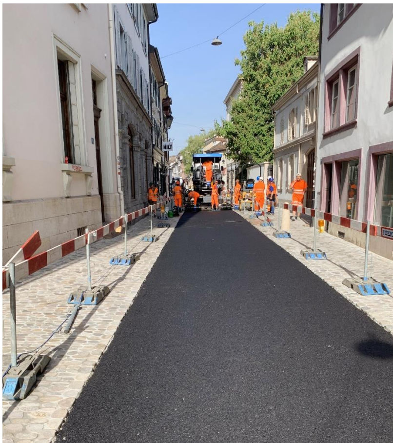
Abbildung 7 Belagseinbau Pyrolysekohle -Asphalt in der St. Alban Vorstadt, Kanton Basel - Stadt im August 2023
