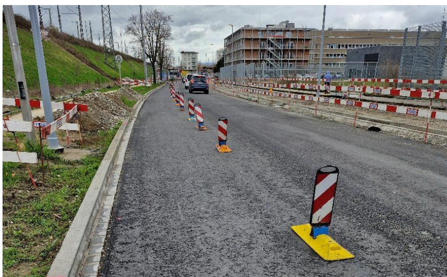
Abbildung 8 Belagseinbau Pyrolysekohle -Asphalt in der Freiburgerstrasse, Kanton Basel – Stadt 2023
