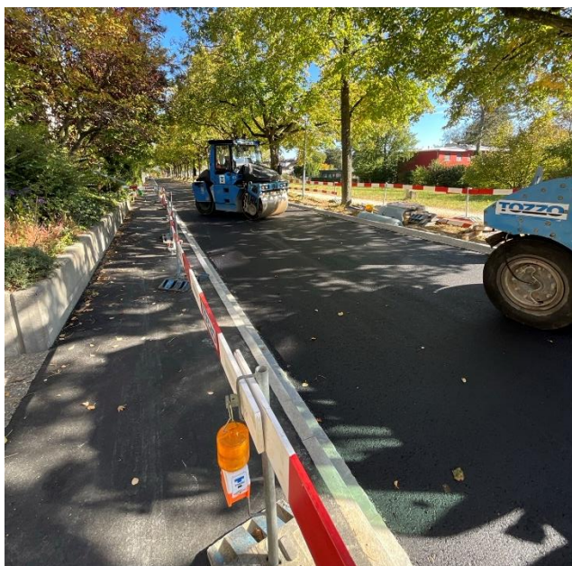
Abbildung 9 Belageinbau Pyrolysekohle -Asphalt in der Reservoirstrasse, Basel Kanton Basel - Stadt 2023
