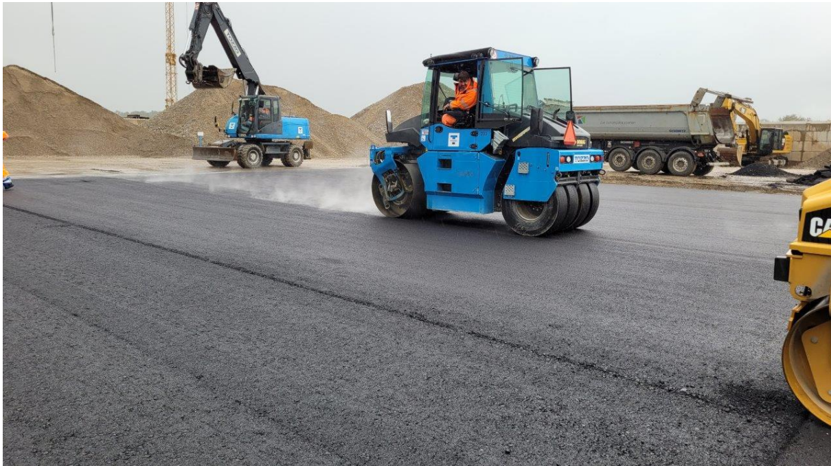
Abbildung 6 Belagseinbau Pyrolysekohle - Asphalt Versuchsfläche habö AG im September 2022
