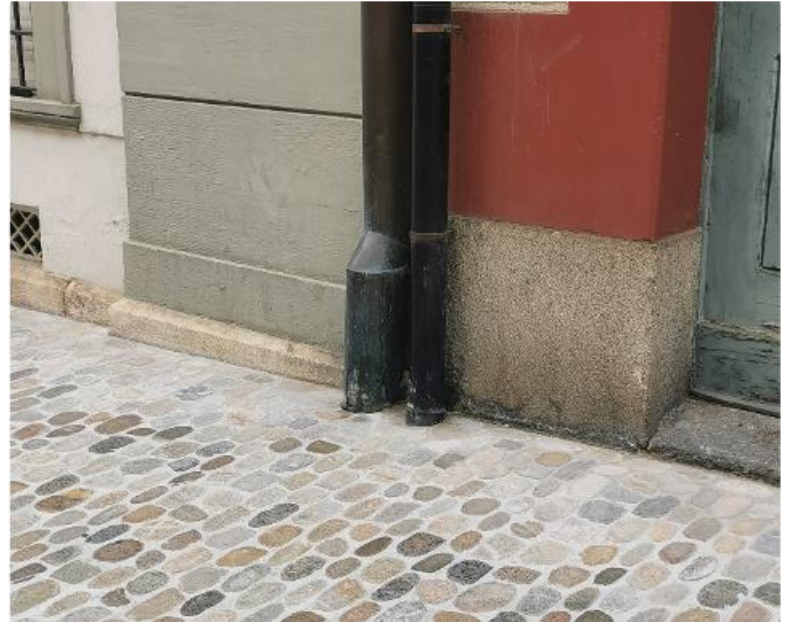
Neu: In Sammelleitungen unterirdisch
