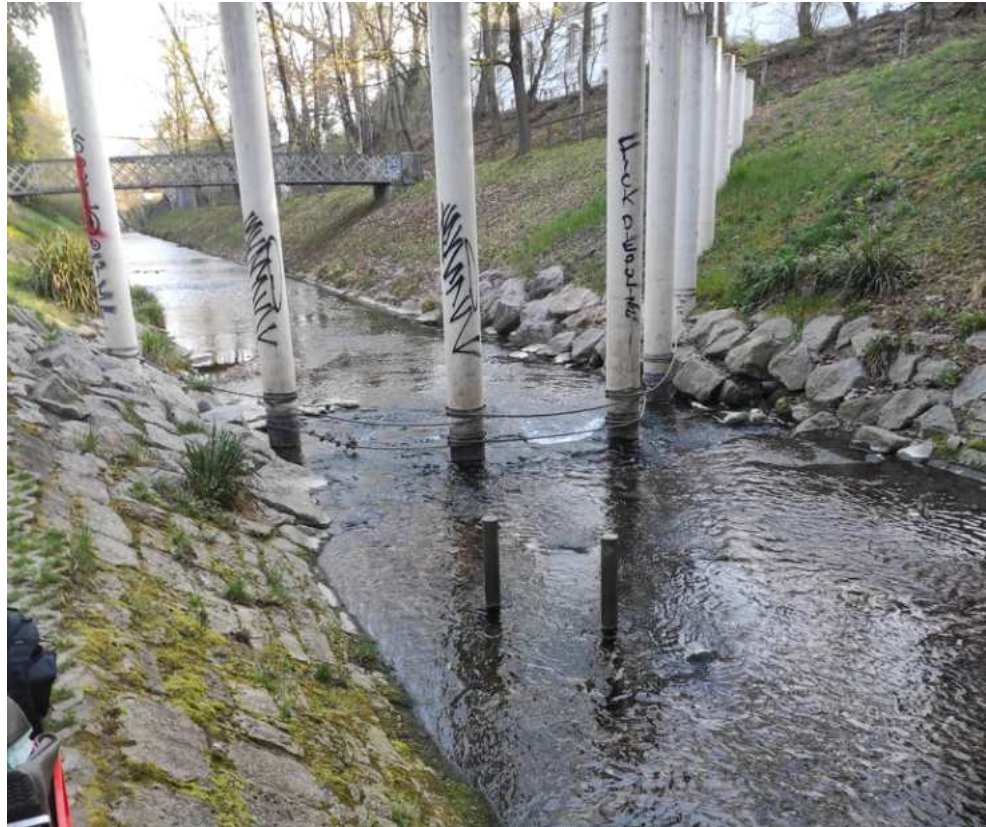
Abbildung 5: Birsig unterhalb des Dorenbachviadukts (BG2). Die Säulen im Querprofil sollen Verkläusungen im weiter unten liegenden Bereich der Eindolung verhindern.
