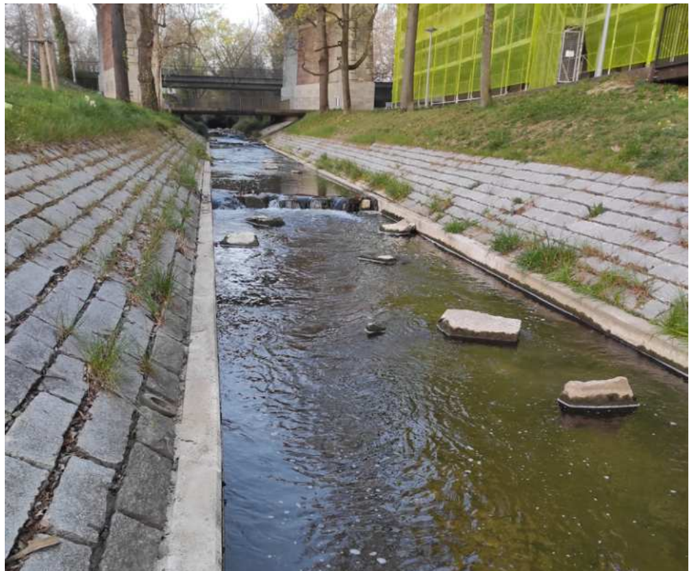
Abbildung 4: Der Birsig kurz vor seiner Eindolung im Innenstadtbereich (BG1) fliesst in einem Trapezprofil.
