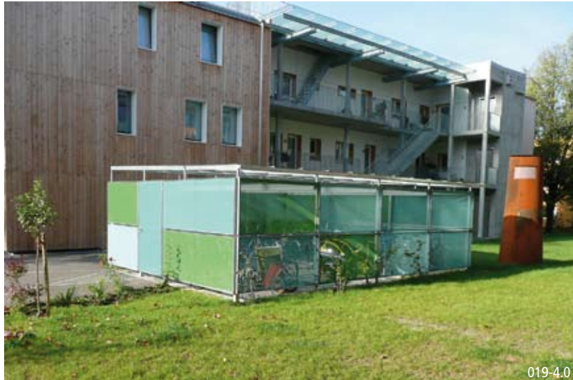
Freistehender Velounterstand mit Seiten- und Rückwänden
