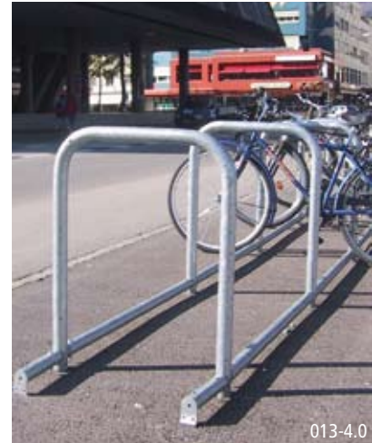
Anlehnbügel mobil, ohne Fundament
