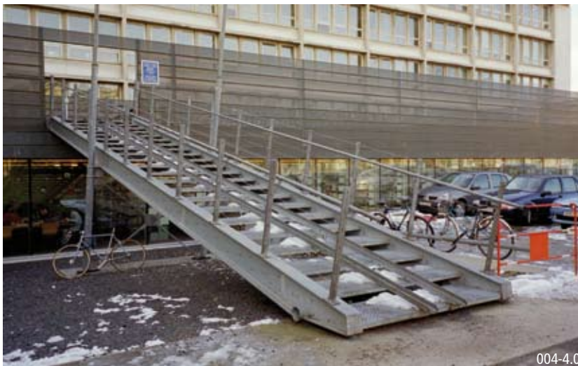
Treppe mit Schieberinnen
