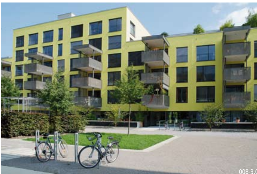
In Siedlung integrierte Veloparkplätze für Kurzzeitparkierung
