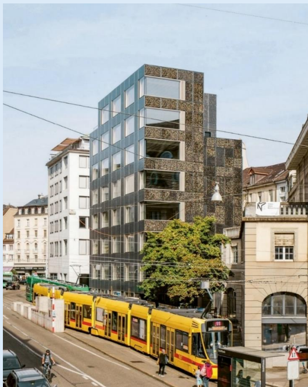
Una delle particolarità di questo edificio è il suo impianto fotovoltaico che ricopre tutte le facciate. ©hochparterre.ch
