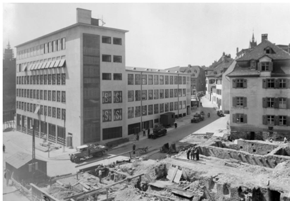
Altstadt-Idylle, wie sie verschwunden ist: Die Petersgasse im Jahr 1937 nach dem Abbruch der Häuser Nr. 2-18. Links der Rohbau der Kantonalbank, dahinter der Bauzaun des Spiegelhofs.
