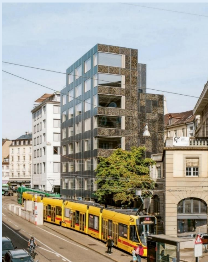
L'une des particularités de ce bâtiment est son installation photovoltaïque qui recouvre toutes ses façades. ©hochparterre.ch
