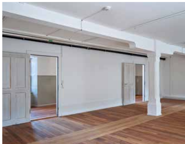
Kasernenzeitliche Oberflächen und Details wurden respektiert und prägen den Raumcharakter weiterhin mit, wie die Fotos auf dieser Doppelseite zeigen. Aktuelle Interventionen zeichnen sich stellenweise ab (z.B. rechts unten: Bodenreparatur in Längsrichtung nach statischer Verstärkung). Exemplarisch sind einige mittelalterliche «Fenster» freigelegt und konserviert worden (linke Seite: sandsteinfarbene Wandfassung mit aufgemalten hellen Quaderfugen).
