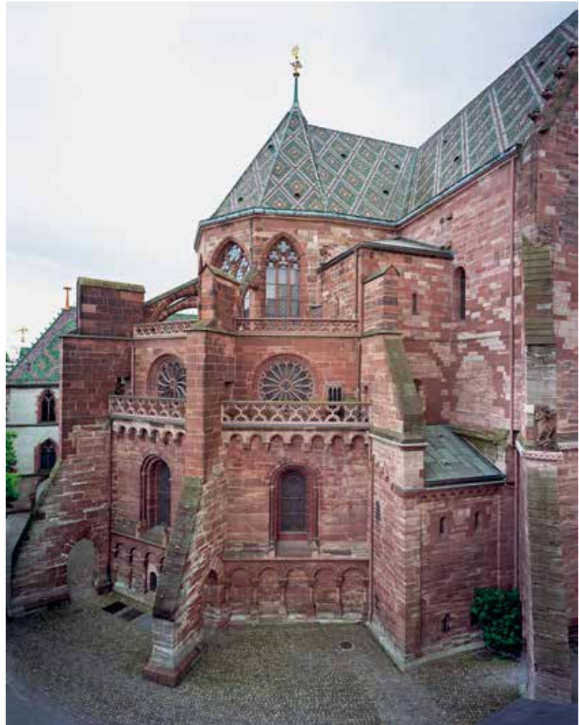
Der Chor des Basler Münsters von Nordosten. Die heute zweigeschossige Alte Sakristei liegt im Winkel zwischen Querhaus, Chorumgang und Strebepfeiler.
