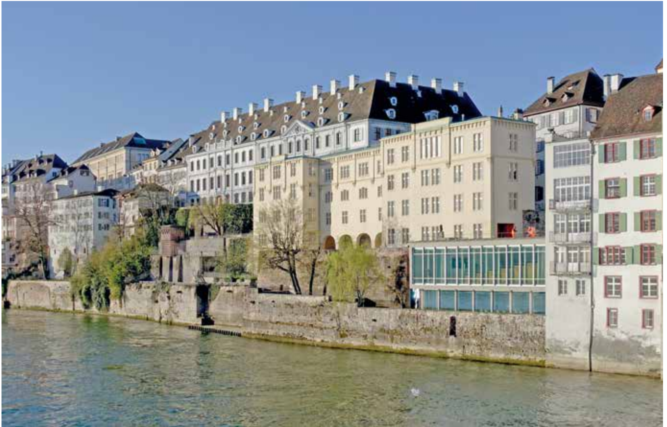
Die Rheinufermauer vor der Sanierung 2020.
