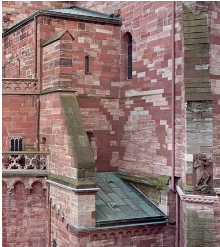
Dunkle Sandsteine sind die letzten Spuren des einst vorhandenen 3. Geschosses der Alten Sakristei. Sie ersetzen beim Abbruch des Geschosses 1884 die ausgebrochenen Spitzbögen des Gewölbes und den schrägen Dachansatz. Auch die Tür zur Chorempore wurde mit ihnen zugesetzt. Der Strebepeiler wurde beim Abbruch des Geschosses verkleinert.
