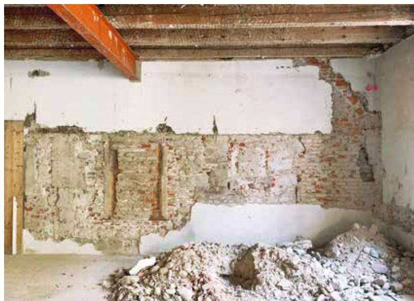
Klingentalkirche, südöstliche Ecke der Leutkirche mit der Rückwand des einstigen Lettners. In der Mitte ein ehemaliges Fenster aus nachreformatorischer Zeit. Zu seinen beiden Seiten senkrechte Steinsetzungen. Es sind die zurückgearbeiteten Dienste des Lettnergewölbes. Rechts oben der ehemalige Spitzbogen des südlichen Gewölbes und darunter die zugemauerte Tür zur ehemaligen Katharinenkapelle (beides mit Backstein vermauert). Die Deckenbalken stammen aus dem 18. Jahrhundert.
