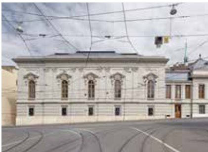
Wegen des Tramlärms wurden die Fenster des Musiksaals 1964 zugemauert. Damit zeigte sich der Saal nach aussen wie erblindet, während man sich im Innern in einem Walfischbauch wählte. Mit der Öffnung der Fenster kann abends das Saalgeschehen auch von aussen wieder erlebt werden.
