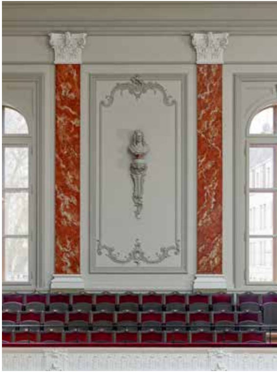
Wandfeld zwischen zwei Pilastern im grossen Saal gegen den Steinenberg. Die Komponistenbüsten bilden heute farblich wieder eine Einheit mit der grauen Fassung der Stuckdekorat.
