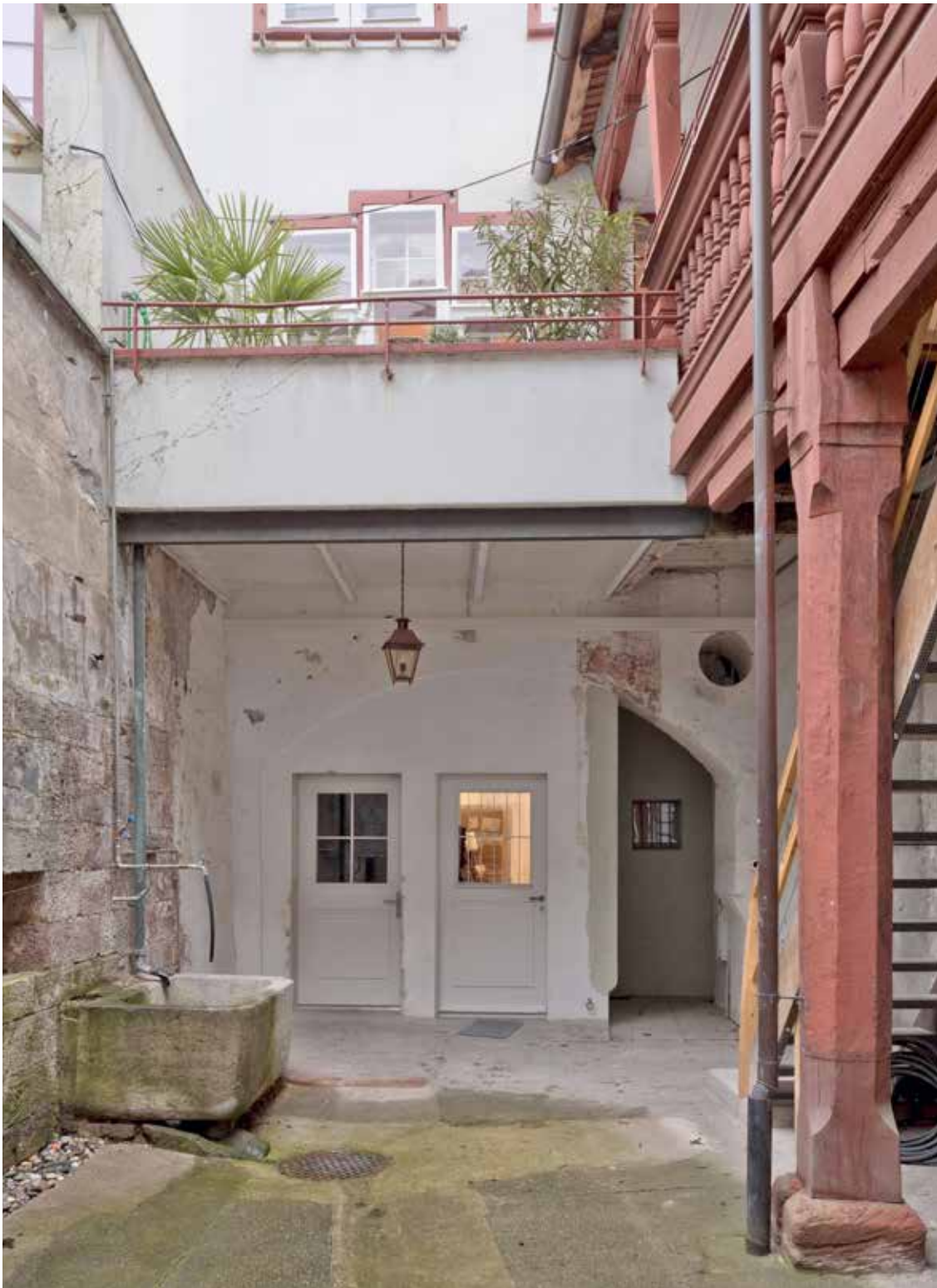
Spalenberg 22, Innenhof. Die Rückseite des Vorderhauses ruht auf einem farbig gefassten Segmentbogen, der die gesamte Hausbreite überspannt. Ein Oculus wie rechts war vermutlich auch links vorhanden. Rechts die Laube und der Abgang in den Keller.
