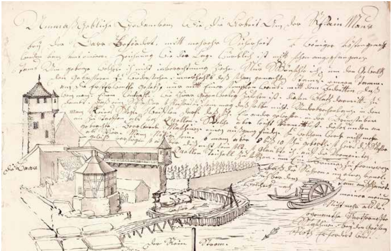
Darstellung eines Kastendamms an der beschädigten Stadtmauer beim heutigen Waisenhaus. Zeichnung von Franz Feyerabend aus der zweiten Hälfte des 18. Jahrhunderts.
