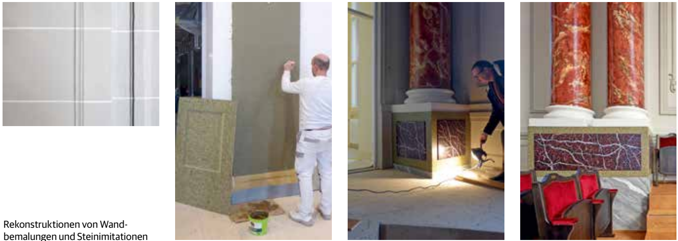
Von links nach rechts: Aufgemalte Fugen im Durchgang zwischen grossem Saal und Künstlergarderobe; Wiederherstellung der Steinimitationen an den Scheinpilastern; Bemusterung und fertiger Zustand einer Marmorimitation an einem Säulenpostament im grossen Saal.
