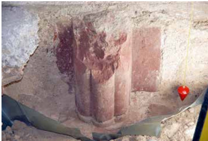
Fuss einer Gewölbstütze von 1280/90 an der Lettnerückwand. Er blieb erhalten, weil der Boden beim Umbau zur Kaserne 1860–1863 aufgeschüttet wurde.
