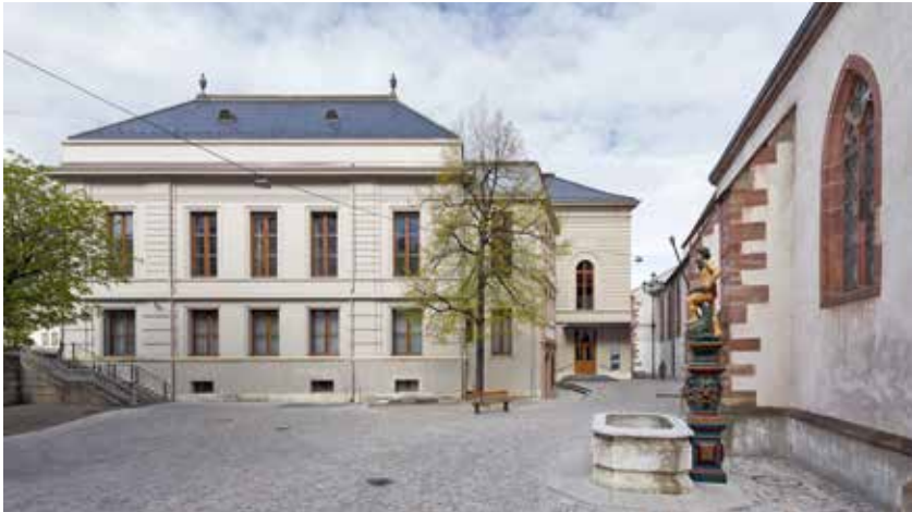
Zwischen Hans Huber-Saal und Barfüsserkirche ist mit dem neuen Anbau an den Musiksaal ein Platz mit «Altstadtcharakter» entstanden.
