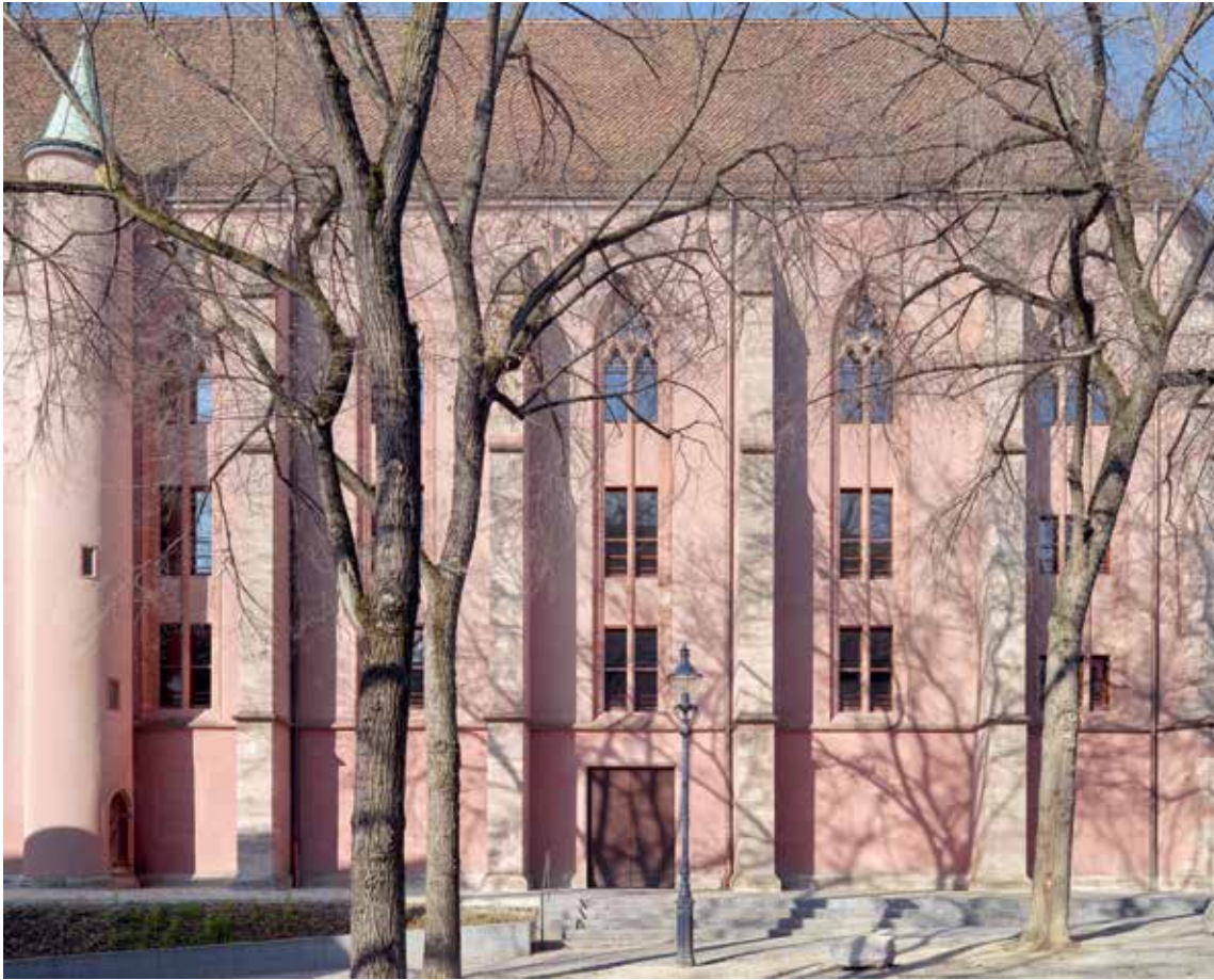
Südflanke des 1293 vollendeten Chors der Klingentalkirche nach Schliessung störender Fenster aus dem 19. Jahrhundert im Sockel. Die neue Tür zum Ausstellungsraum Klingental befindet sich an der Stelle eines im 18. Jahrhundert vorhandenen Einfahrtstors.
