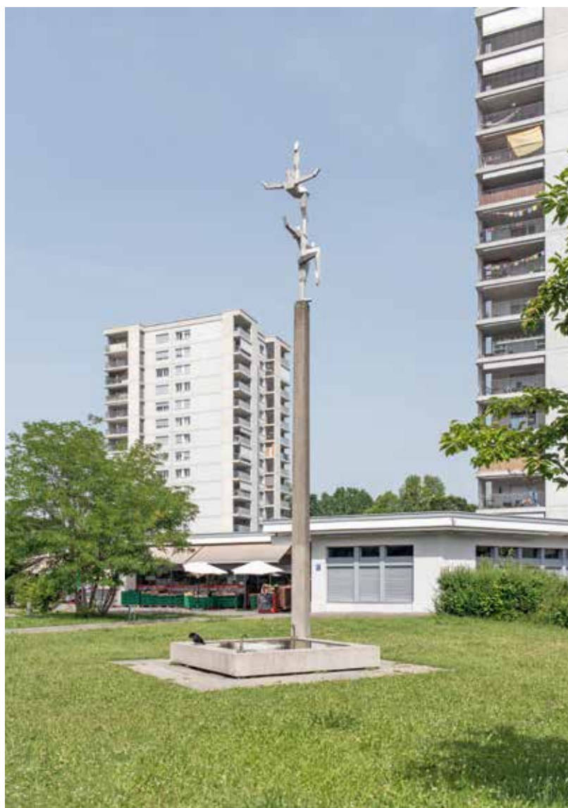
Für das Siedlungsinventar galt es insbesondere auch Anlagen aus der Nachkriegszeit zu berücksichtigen. Etwa die Siedlung Gutschick (1959-1964, Heinrich Raschle), ein charakteristisches Beispiel für die damals propagierte differenzierte Bebauung mit unterschiedlichen, in einen grosszügigen Grünraum eingebetteten Gebäudetypen in freier Anordnung.
