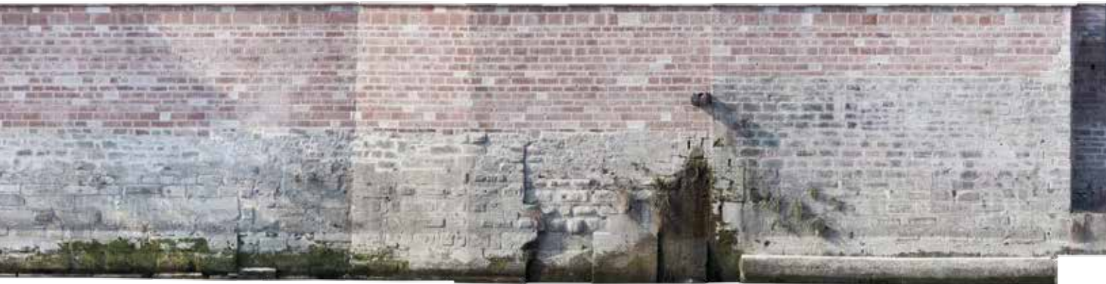
Fotogrammetrische Aufnahme der Ufermauer unterhalb des Gartens am Rheinsprung.
