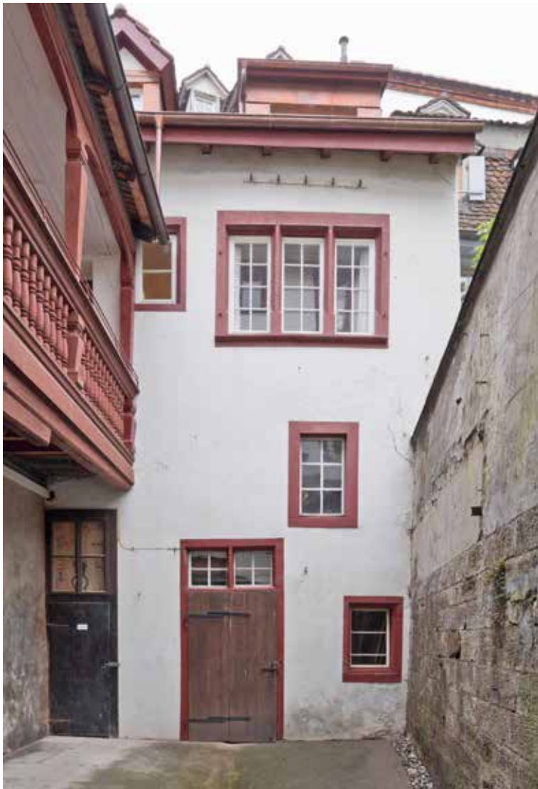
Hoffassade des Hinterhauses. Der Zugang in die obere Etage erfolgt über die Laube von 1684. Das Geschoss liegt fünf Stufen höher als im Vorderhaus. Grund ist das sehr hohe Erdgeschoss, das als Lager oder Abstellplatz für Karren genutzt wurde.
