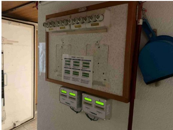
Elektrotableau mit Waschkartensystem
