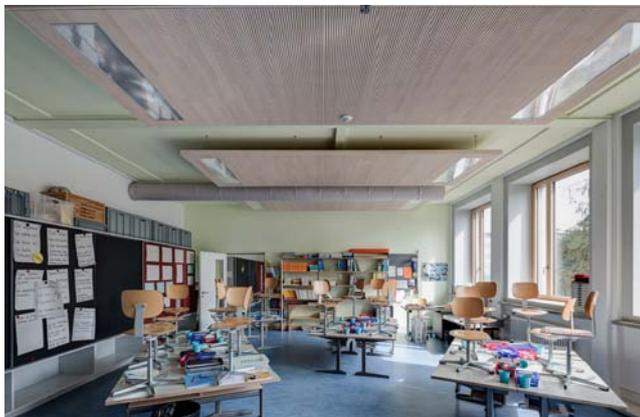
Klassenzimmer im Vischer-Bau des Schulhauses Hirzbrunnen mit abgehängten Akustikpaneelen zur Minderung der Nachhallzeiten. In die bestehenden Fensterrahmen wurden neue Wärmeschutzverglasungen eingebaut.
