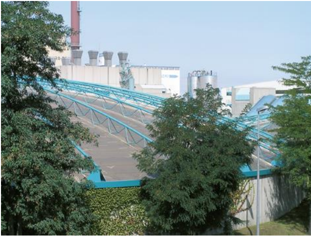
Abwasserreinigungsanlage in Kleinhüningen
