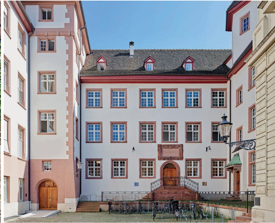
Hindernisfreier Zugang Domhof
