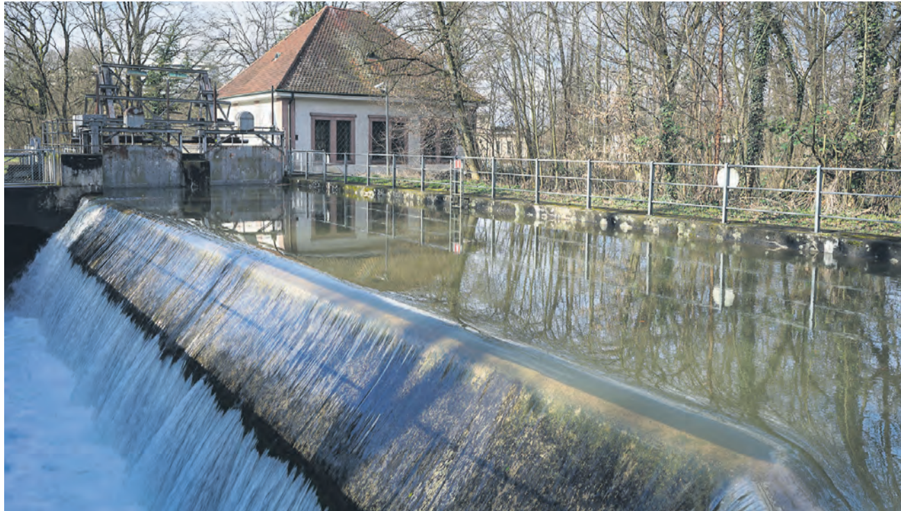
Das Kraftwerk Riehenteich in den Langen Erlen produziert seit hundert Jahren Strom.
