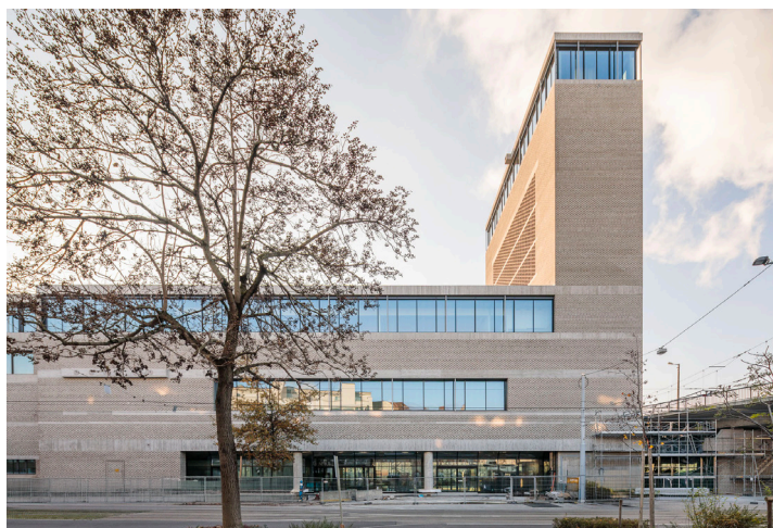
Haupteingang Vogesenplatz November 2025 © Derek Li Wan Po
