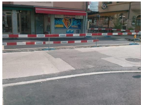
Tragschicht: Flick an Flick im Kreuzungsbereich
