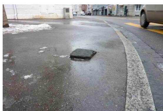
Frosthebung (keine Frostsicherheit)
