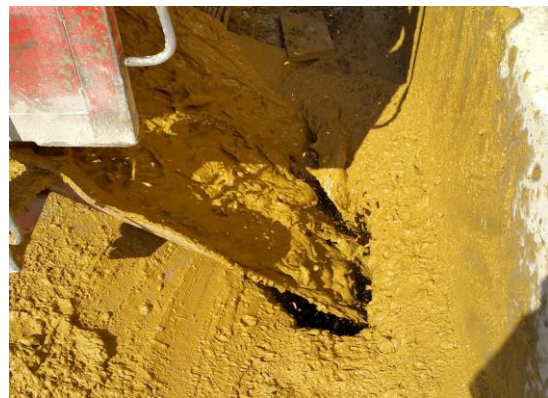
Verfüllen von unerwünschten Hohlräumen (Rühlwand)
