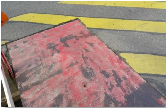
Versenkte Stahlplatte in Fahrbahn
