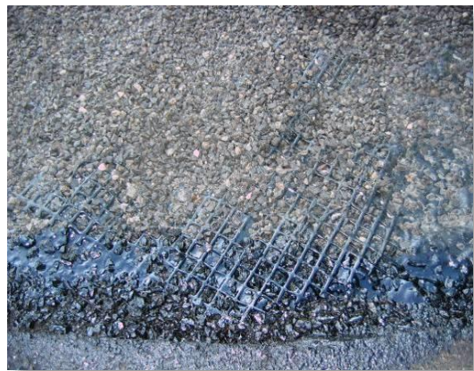
Stressabsorbierende Mastix Inlay (SAMI) spannungsabsorbierende Membrane
