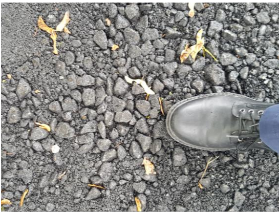
Entmischte "definitiv" eingebaute Tragschicht
