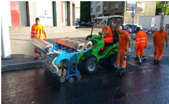
Carbophalt-Netz wird in einem Kreisel verlegt
