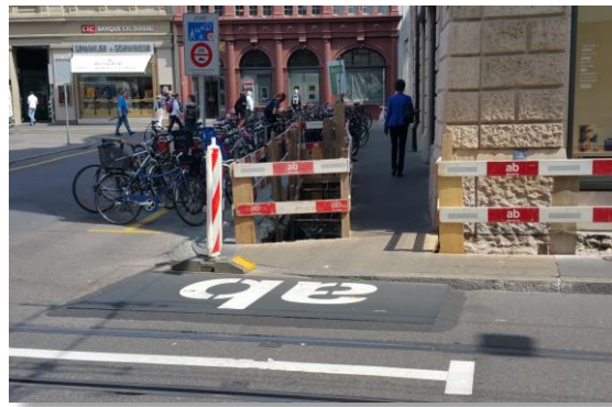
Versenkte Holzdielen mit angeramppter Stahlplatte
