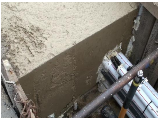
Flüssigboden nach Ausbau des Schotts
