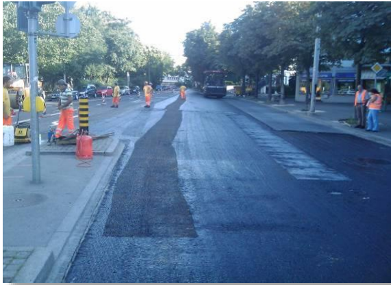
Verlegtes Carbophalt-Netz
