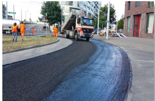
SAMI mit vorumhülltem Splitt wird eingebracht
