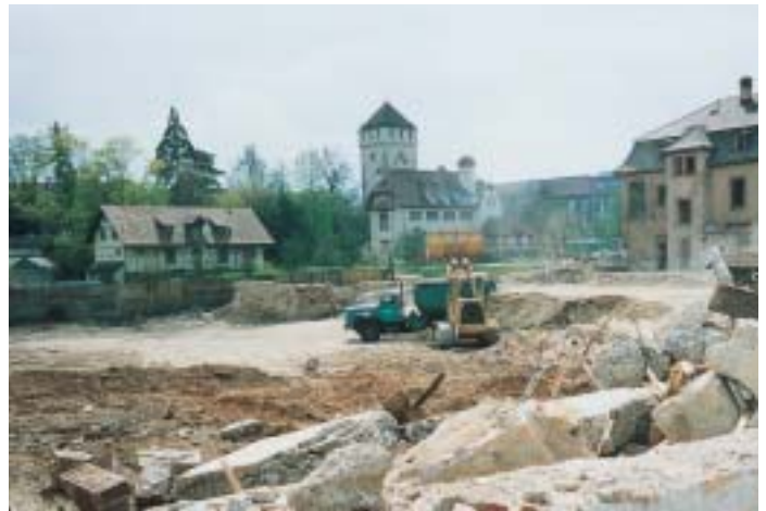
Abb. 20 Beginn der zweiten Bauetappe mit dem Abbruch der Schlachthofgebäude und dem Absenken des Areals gegen den Rhein hin. Rechts die Veterinärvilla und links das Fachwerkgebäude der Alten Stadtgärtnerei, in der die mechanische Werkstatt und im Untergeschoss die Schreinerei untergebracht waren. Foto: Th. Stauffer
