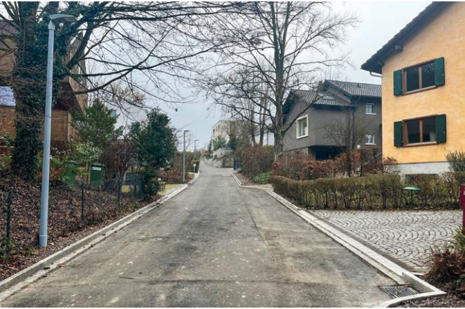
Der Wyhlenweg nach der Umgestaltung: private und öffentliche Areale durch Randabschluss getrennt, effiziente Strassenentwässerung durch Einlaufschächte, Kandelaber hinter Strassenrand ermöglichen saubere Reinigung, Hangsicherung (im Hintergrund) durch zwei gestaffelte, sich organisch ins Strassenbild einfügende Bruchsteinmauern. Foto: Daniel Schoop
