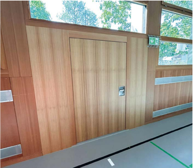
Umbau Notausgang, Foto: Michael Fischer, Jauslin Stebler AG
