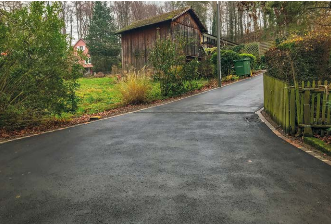
Der Linsbergweg nach der Umgestaltung: neue Randabschlüsse ermöglichen einen sauberen Belagseinbau, der seitlich nicht ausbricht und daher dauerhaft ist, eine effiziente Strassenentwässerung schützt bei Starkregenereignissen. Foto: zVg Jauslin Stebler
