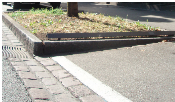
Abb. 203.05a Ausgeführtes Werk Rabattenschutz
