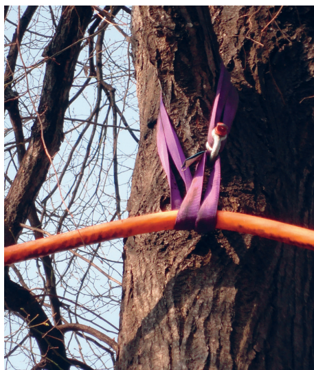
Abb. 202.01 I+m Kabelbefestigung
