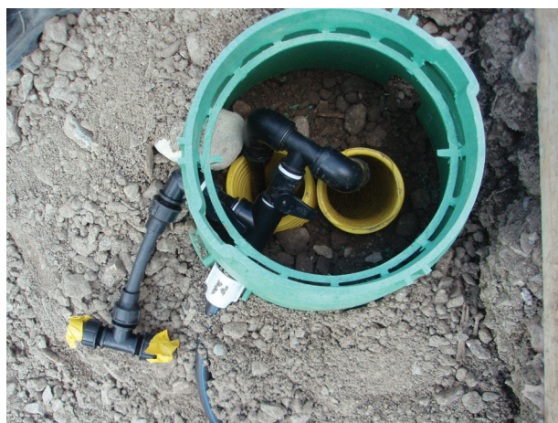
Abb. 203.07d: Bewässerungsverteilschacht
