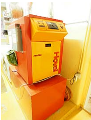
weiterer Ausschnitt Waschküche/Heizraum mit Gas-Zentralheizung im KG
