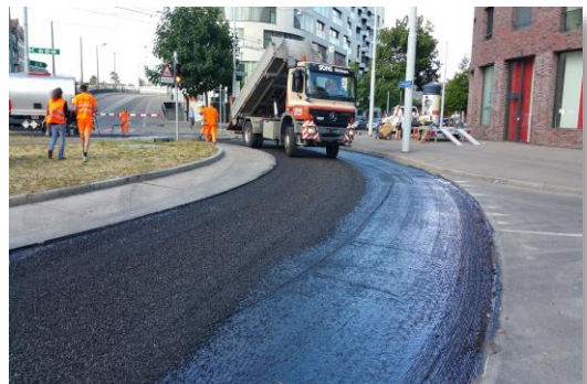
SAMI mit vorumhülltem Splitt wird eingebracht
