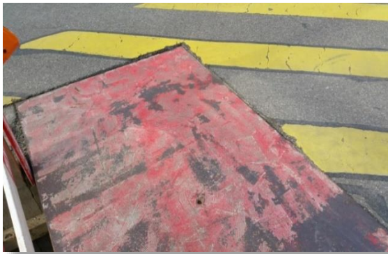
Versenkte Stahlplatte in Fahrbahn
