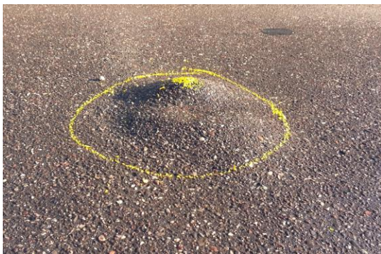
Dampfblase unter Gussasphalt ("Warze")
