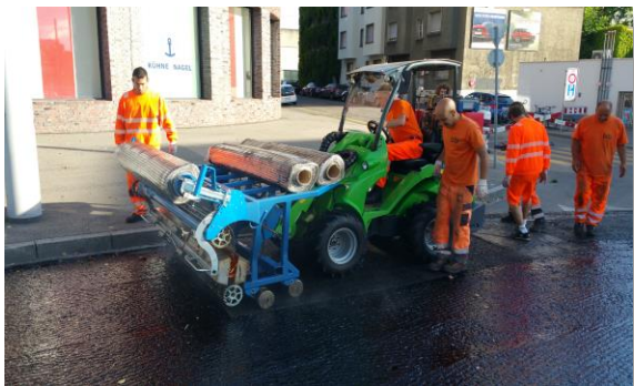
Carbophalt-Netz wird in einem Kreisel verlegt
