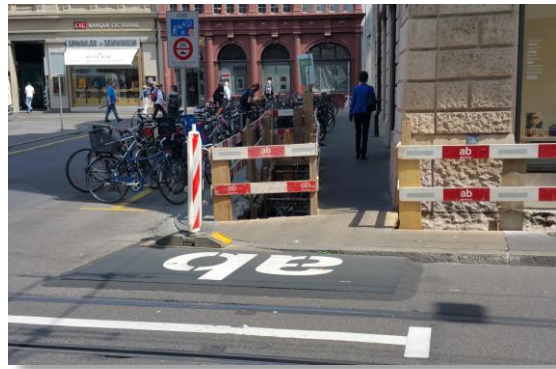
Versenkte Holzdielen mit angerampter Stahlplatte
