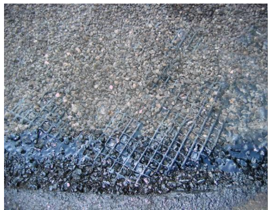
Stressabsorbing Mastix Inlay (SAMI) spannungsabsorbierende Membrane
