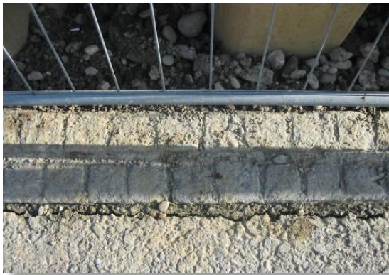
Abgehängter Randabschluss (Baugrube)
