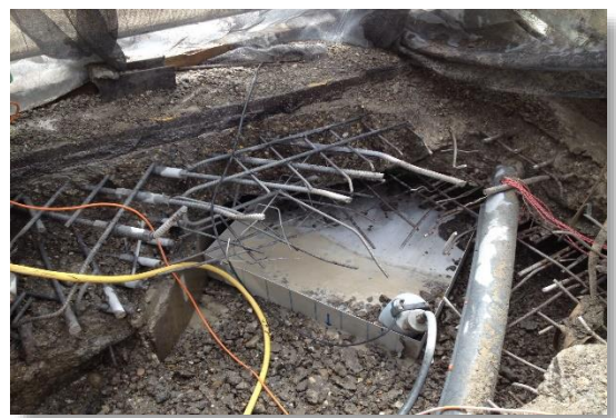
Durchtrennen statischer Brückenbewehrung
