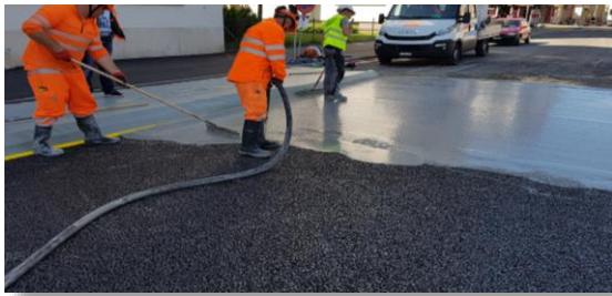
Verfüllen des bituminösen Belags mit der Schlämme
