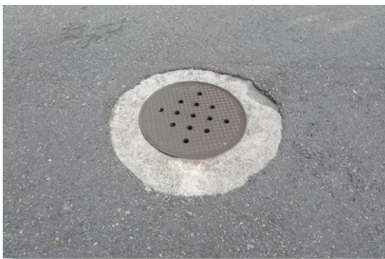
Beton statt Belag (Blick auf Binderschicht)
