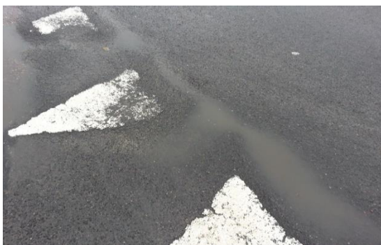
Übermässiger Abrieb in 3-jährigem Testbelag
