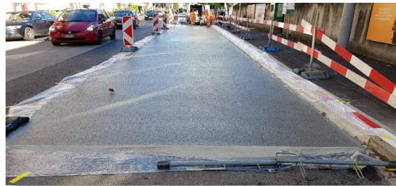
Frisch eingebauter VB11 (hier das Produkt CONFALT)
