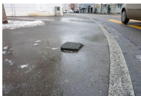
Frosthebung (keine Frostsicherheit)
