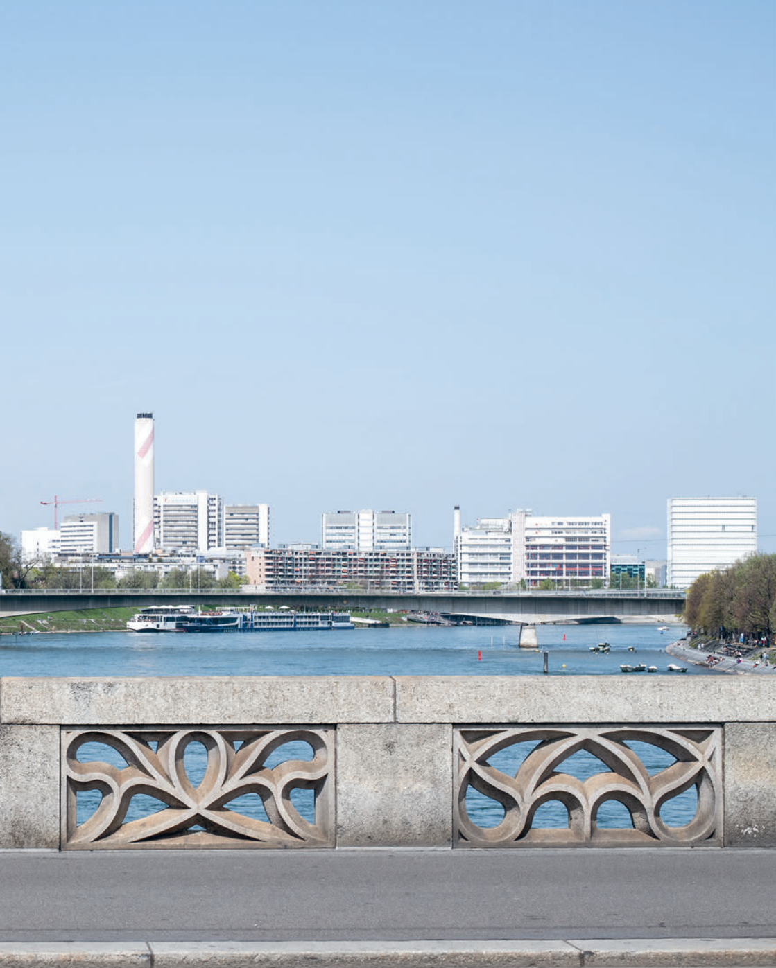
Am Bau der Rheinbrücke im 13. Jahrhundert beteiligten sich die Juden in Basel massgeblich.
