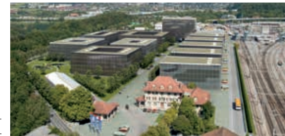
Der neue Entwicklungsschwerpunkt Wankdorf kann von allen S-Bahn-Durchmesserlinien ohne Umwege bedient werden.
