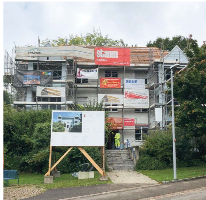
Fassadensanierung, Foto: Andres Linder, externer Bauverwalter
