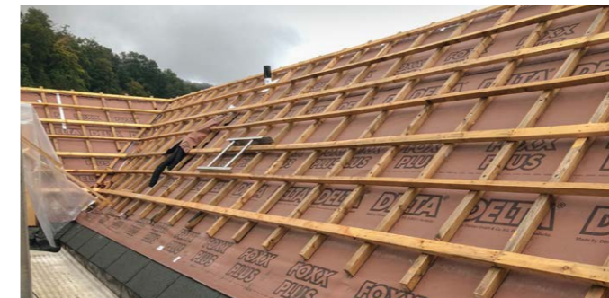
Dachsaniierungen, Foto: Andres Linder, externer Bauverwalter
