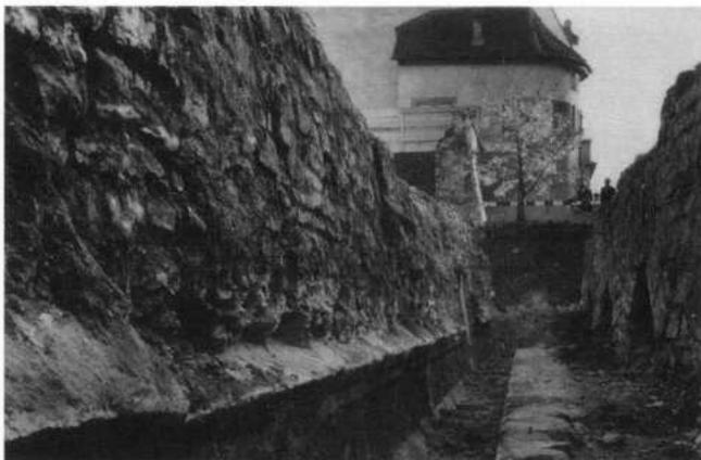
Abb. 17. Petersgraben 35, Fundstelle Nr. 22. Blick nach Süden über die schon teilweise abgebrochene Abwasser-dole hinweg auf die Feldseite der Inneren Stadtmauer. Im Hintergrund der noch stehende Schalenturm Petersgraben 43. – Foto: P. Heman.
