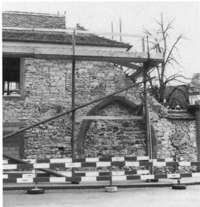
Abb. 4. Lindenberg 12, Hattstätterhof, 1988/40. Blick auf die Hofmauer bzw. die Längsfassade der «Mausefalle» mit dem zugemauerten Spitzbogenportal. Die Zinnen sind zwischen Fenster und Portal noch zu erkennen. – Foto: Basler Denkmalpflege.
