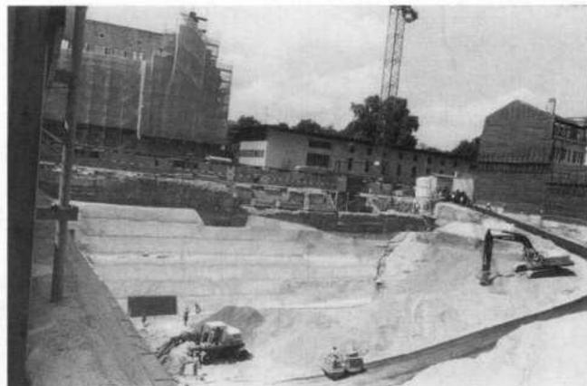
Abb. 25. Petersgraben 49/51, Rosshofareal, 1983/15; Fundstelle Nr. 25. Das Stadtmauerfundament «schwebt» über der Baugrube. – Foto: Dokumentation 1983/15.
