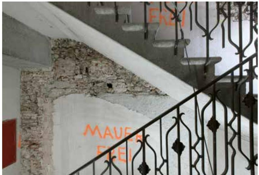
**5** – Nottreppe von 1909, hinten die Freilegungen am untersuchten Brandmauerabschnitt. In der Mauer ist die Baugeschichte der Häuser Zum Roten Haus und Zum Lämmlein (ehemals Marktplatz 2 und 3) überliefert. Die untersuchte Brandmauer blieb bei der Warenhaus-erweiterung von 1975/76 nur erhalten, weil sie als Einhausung der Nottreppe weiterhin ihre Funktion erfüllte.
