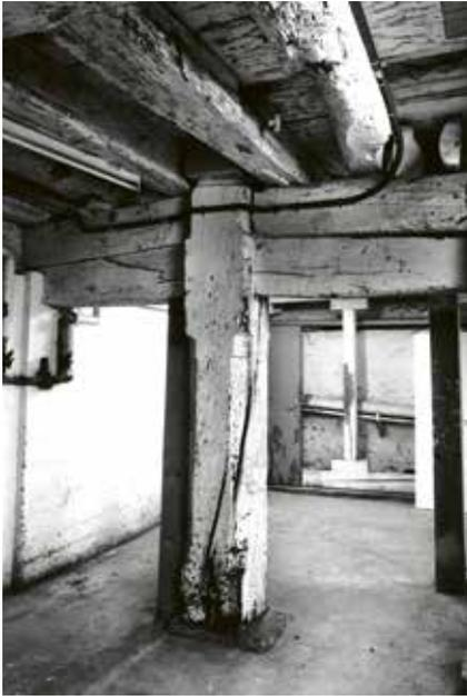
**Stabile Konstruktion:** Die Eichenstütze im Keller hat einen grösseren Durchmesser als gewöhnlich. Sie trägt einen Unterzug, auf dem die Deckenbalken sehr eng aneinander aufliegen.
