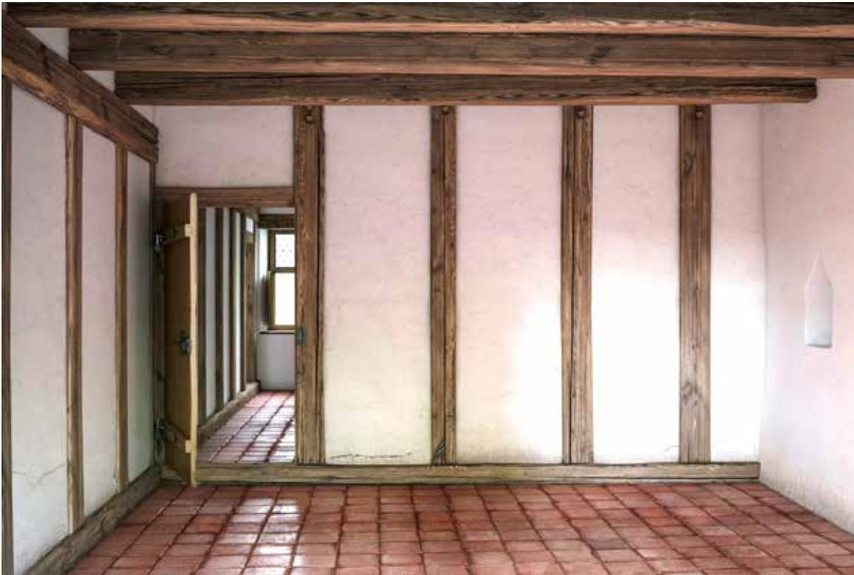
Digitale Rekonstruktion des 2. Obergeschosses mit Blick in Richtung Flur. Der Grundriss, die weiss verputzten Ausfachungen, der Tonplattenboden und die unbemalten hölzernen Bauteile sind nach Befund rekonstruiert. Links sieht man die tragende Innenwand, die quer zu den Deckenbalken verläuft, rechts die westliche Brandmauer.
