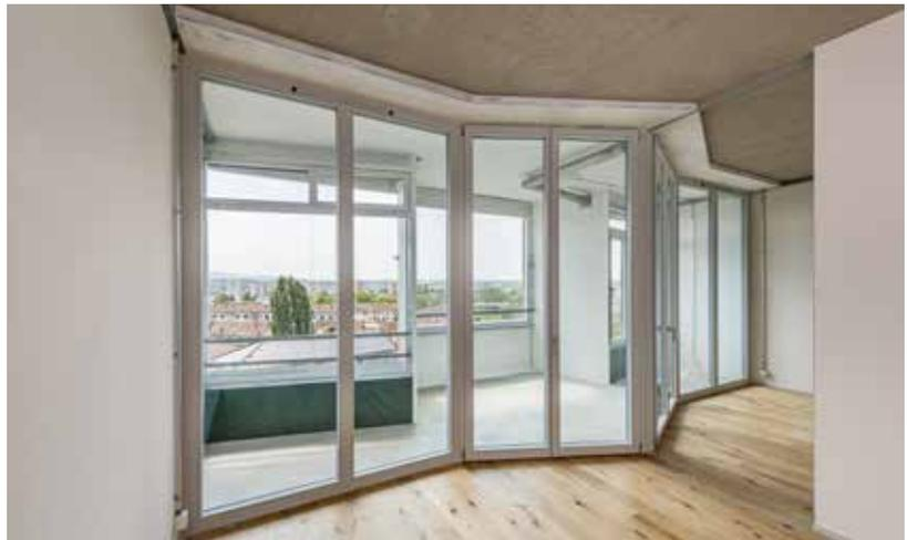
An der Südwestfassade wurde auf der Innenseite eine neue, ebenfalls geknickte und thermisch wirksame Glaswand eingebaut. Dadurch konnte die bauzeitliche Metall-Glas-Fassade maximal erhalten bleiben. Neben dem Ersatz einiger Festverglasungen durch Schiebegläser und dem Anbringen von Absturzsicherungen musste die Fassade nur gereinigt und an wenigen Stellen repariert werden. Der neue Zwischenraum dient nun als Loggia für die neuen Wohnungen.
