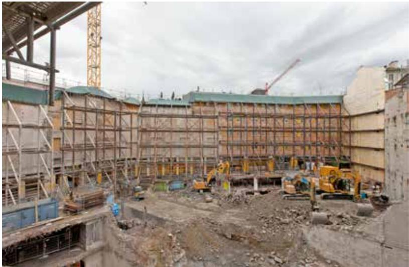
2 – Rückseitige Ansicht der Fassaden nach Sicherungsmassnahmen und Auskernung des Gebäudes: in der Mitte die abgewinkelte Fassade von 1904/05 und 1909. Rechts die Fassade von 1932/33 an der Eisengasse; links diejenige der Erweiterung von 1975/76 am Marktplatz. Ganz rechts im Bild die Stützmauer zum Martinskirchplatz.
