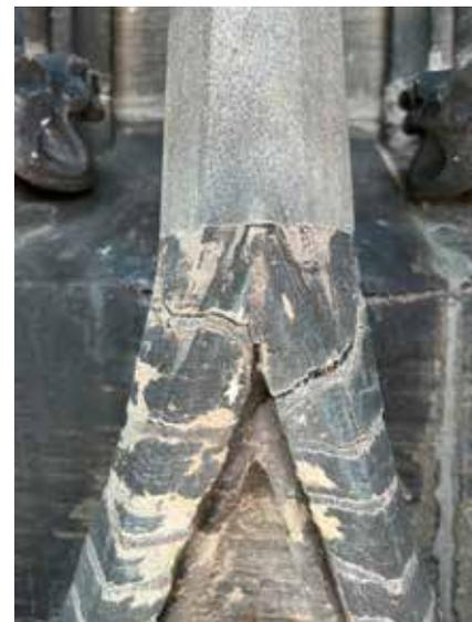
Das ganze Ausmass der Schäden an den Fialen, Dekorationen und Skulpturen des Turmhelms konnte erst nach Erstellung des Gerüsts erfasst werden. Die Schäden waren viel gravierender als vermutet. Auf den Fotos zu sehen sind von links nach rechts: Provisorische Sicherung einer früheren Restaurierung gegen das Herabfallen von erodierten Krabben, Falkennester zwischen den Fialen mit Verschmutzungen, Rissbildungen an einer Fiale.
