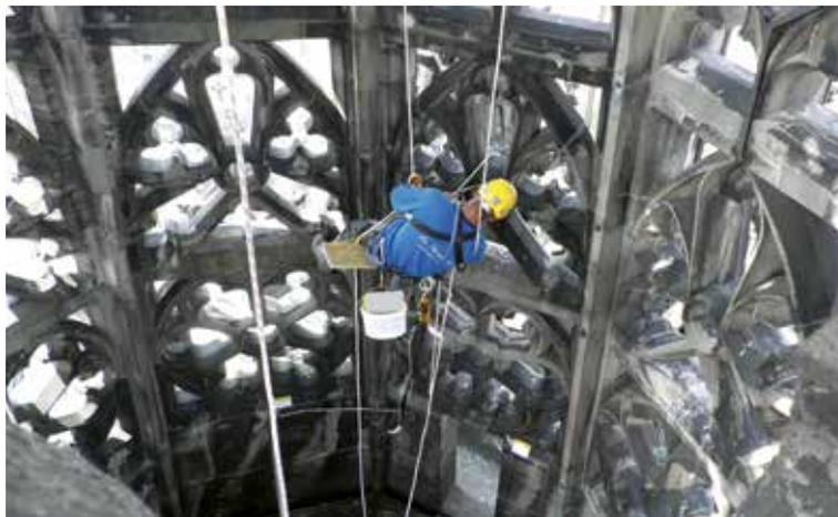
Bereits vor einigen Jahren musste der Turmhelm inwendig beklettert und lose Teile am Sandstein abgeschlagen werden. Ausserdem dienten die Inspektionen der Kontrolle des statischen Zustands des Turmhelms.
