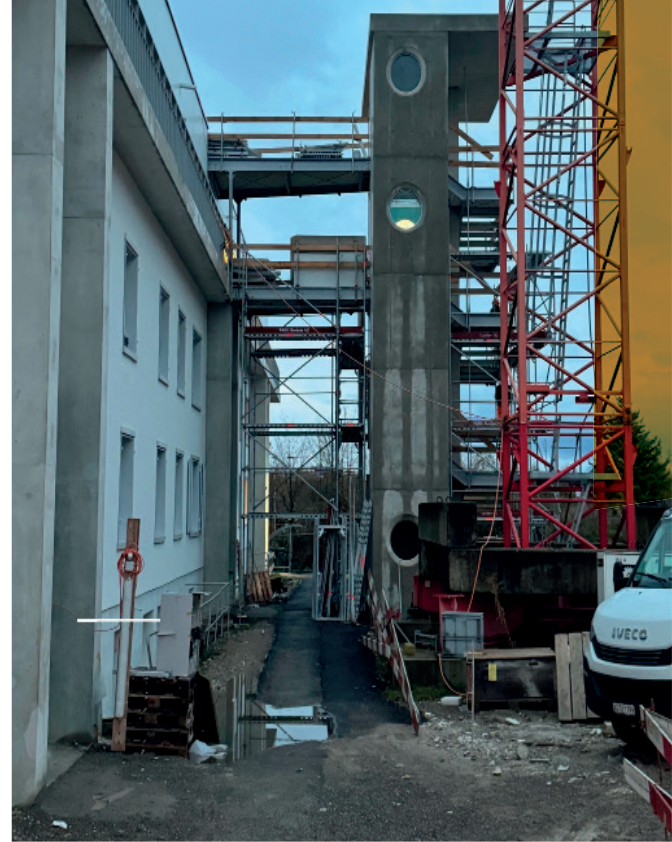
Externer Treppen- und Liftturm an der Landauerstrasse
