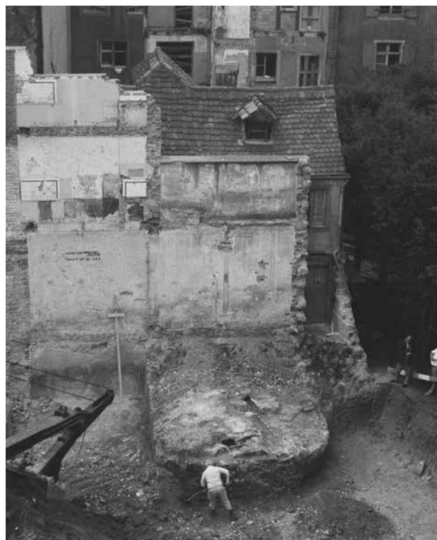
Abb. 9: Basel, 300 n. Chr.: Blick über die Ausgrabungen im Jahr 1973, das Reverenzgässlein würde auf der linken Bildseite anschliessen. Heute ist fast das ganze Gebiet wieder überbaut.
