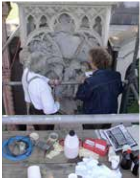
Restauratorische Untersuchung des Grabmals mit Festigungsmustern und Ultraschallmessungen, 2004
