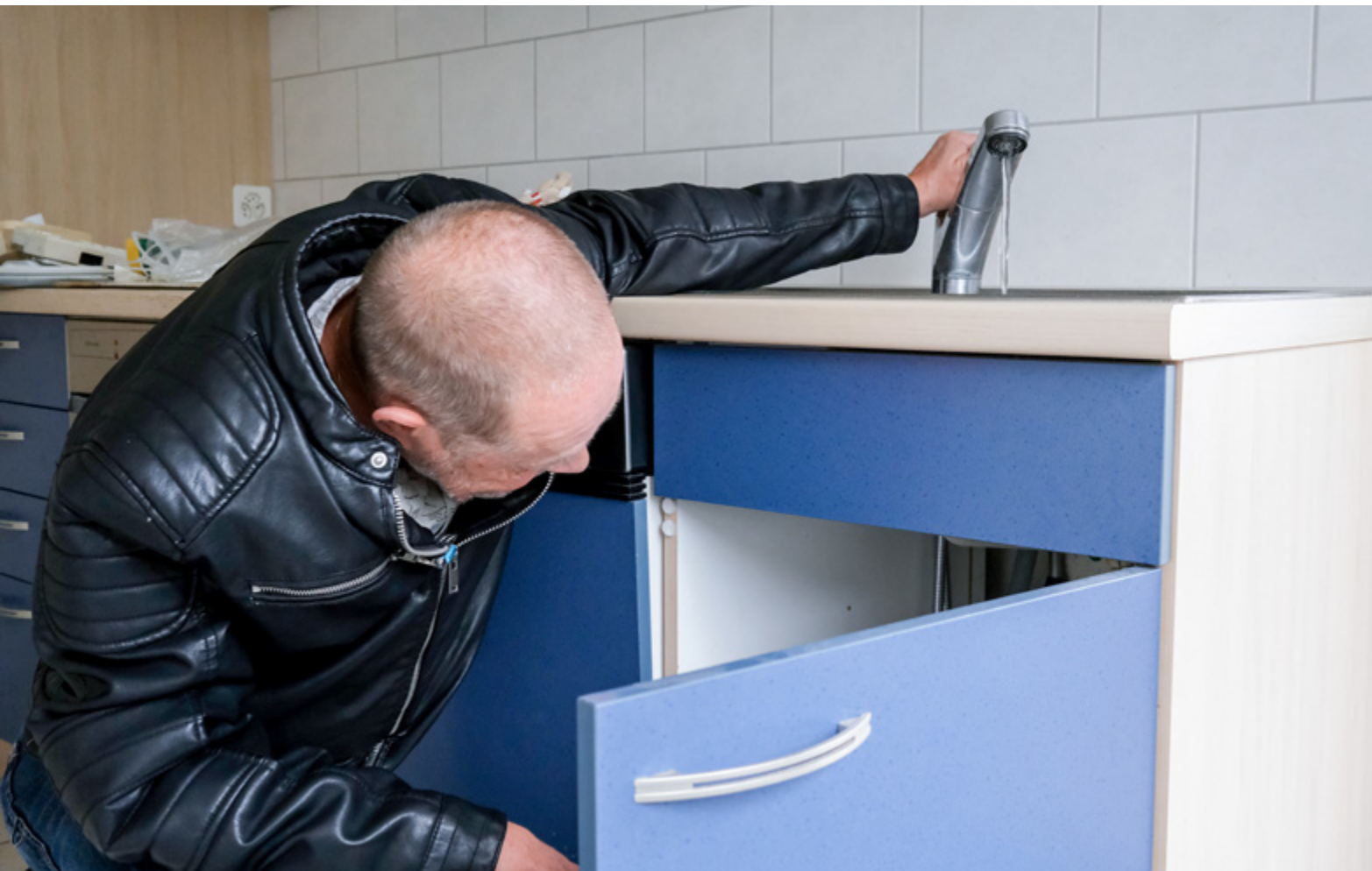
Auf einem monatlichen Kontrollgang prüft Patrick Allemann, ob die sanitären Anlagen noch einwandfrei funktionieren ...
