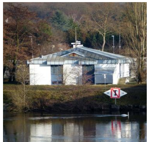
Rheinüberwachungsstation Weil (RüS)
