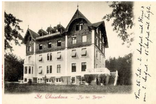
Abbildung 38: Das Haus «Zu den Bergen» kurz nach Fertigstellung 1899 (Postkarte)
