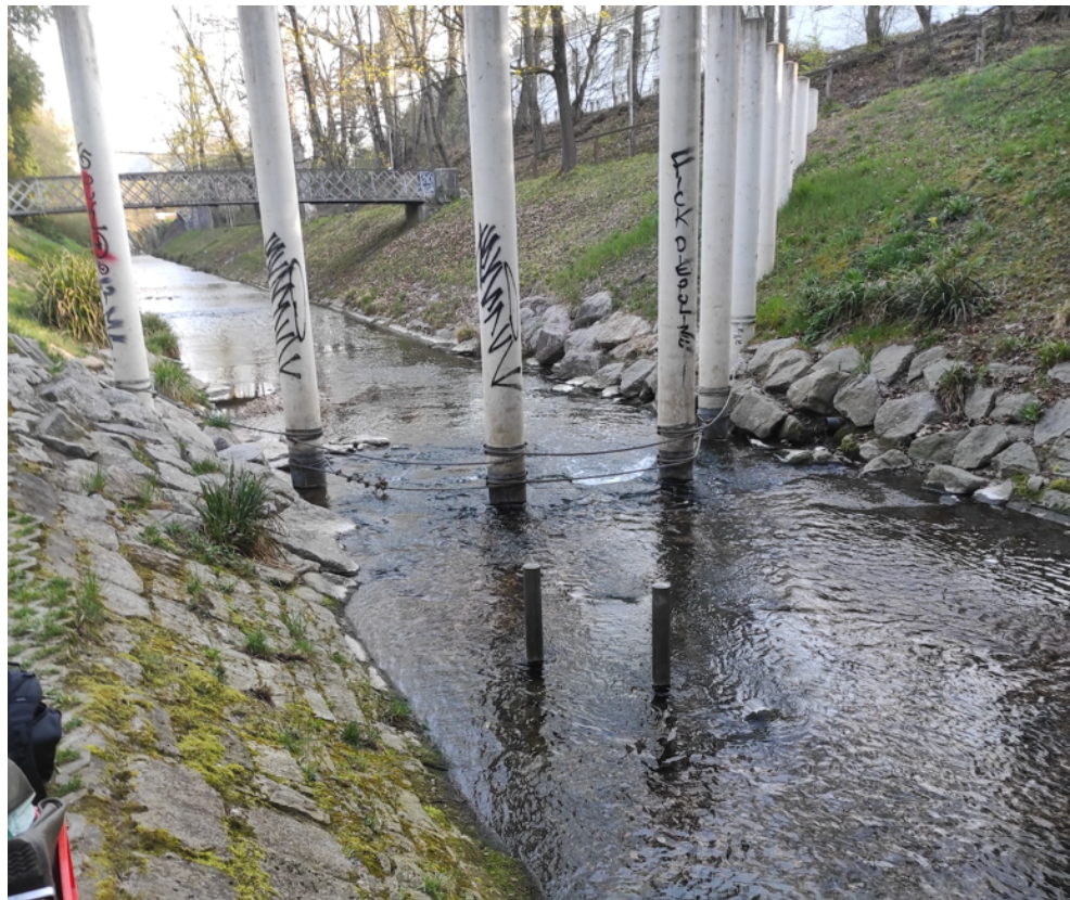
Abbildung 5: Birsig unterhalb des Dorenbachviadukts (BG2). Die Säulen im Querprofil sollen Verklausungen im weiter unten liegenden Bereich der Eindolung verhindern.
