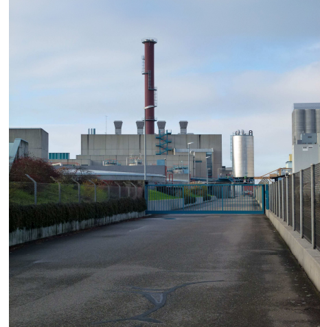
Klärschlammverbrennungsanlage der baselstädtischen Abwasserreinigung
