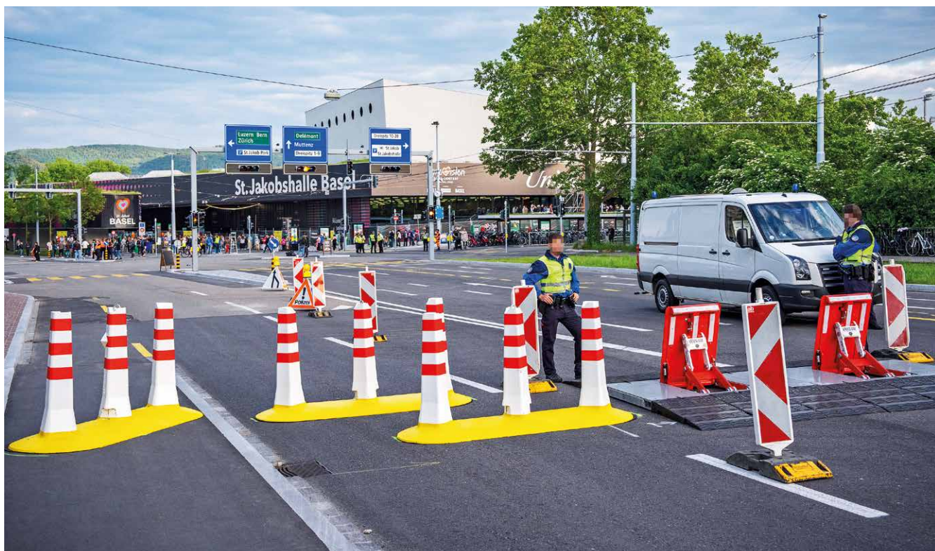
Die Standorte der Fahrzeugsperrungen mussten sorgfältig geplant werden.
