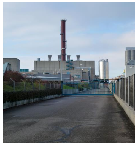
Klärschlammverbrennungsanlage der baselstädtischen Abwasserreinigung
