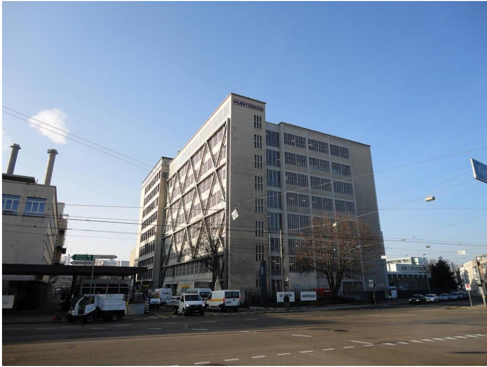
Verstärkungsmassnahmen an einem Gebäude im Klybeckareal. Gut sichtbar ist der aussenliegende Stahlverband an der linken Fassade.
