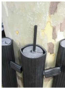
Konstruktionsprinzip und Verschluss des Stammschutzes der Stadtgärtnerei Basel
