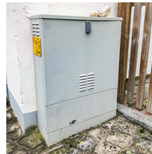
Das Bild zeigt einen Kasten für die Signalverstärkung.
