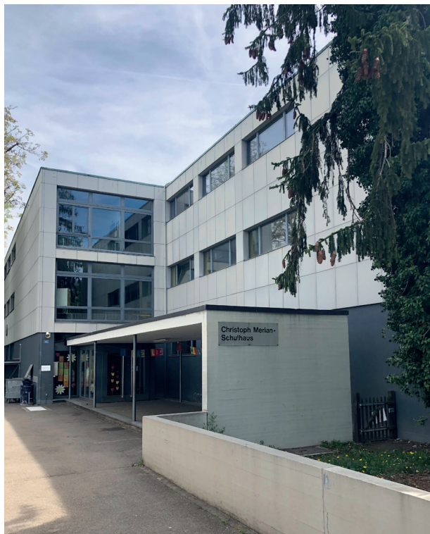
Schulhaus Christoph Merian. © Städtebau & Architektur
