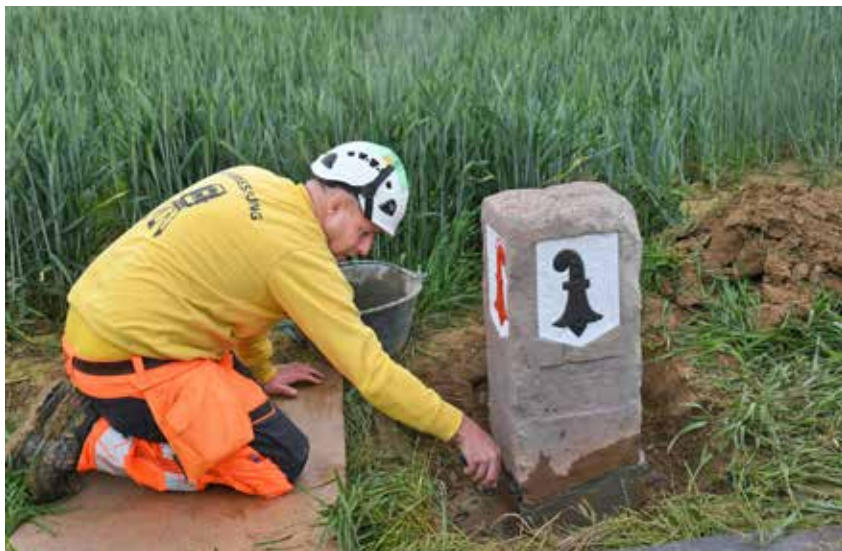
Stein 85, Ausbessern der Bruchstelle.
