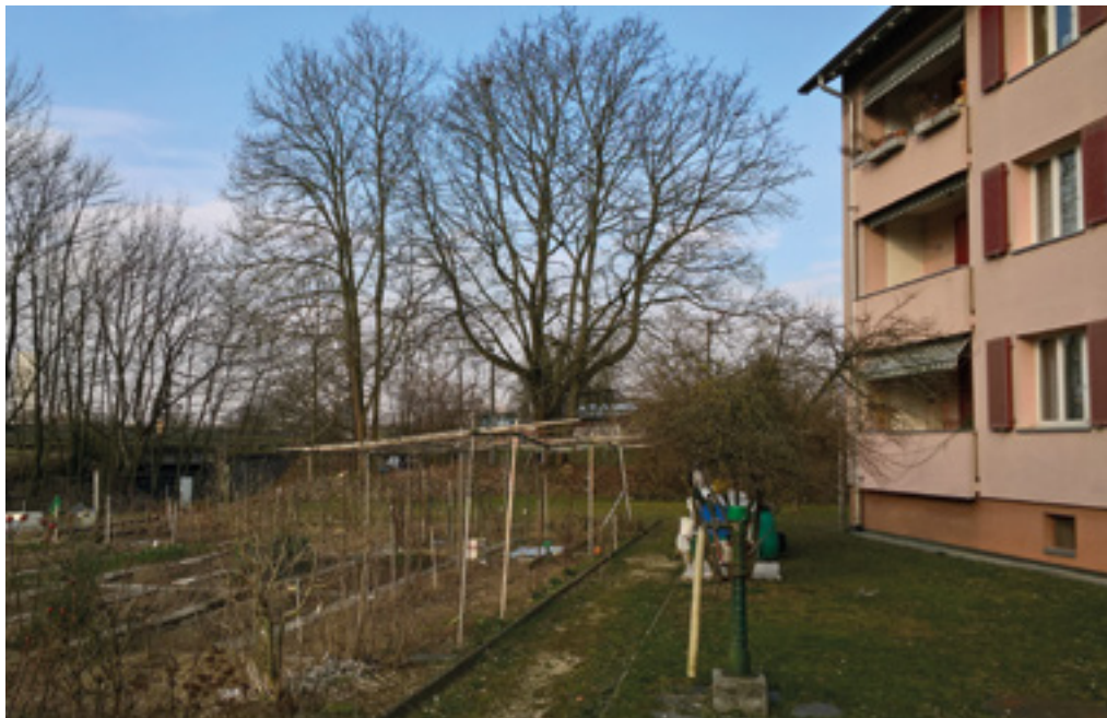
Teilfassade Hirtenweg 28 von Süden Richtung Westen (Aufnahme 2019)
