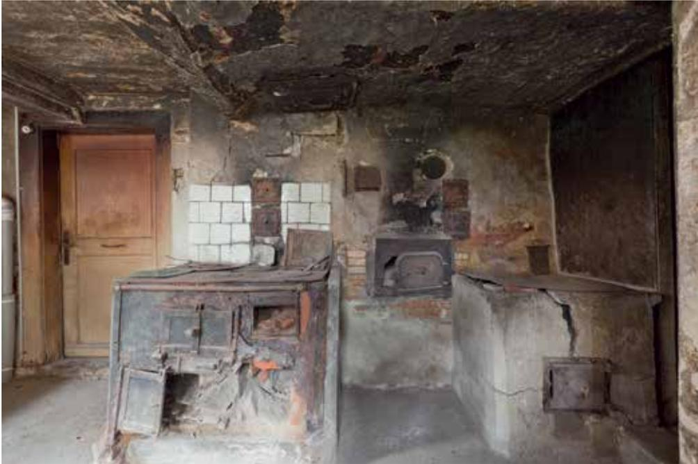
Küche mit Stubentür, Eisenherd, Einfeueröffnung für den Kachelofen in der Stube und Waschofen. Ursprünglich lag hier eine offene Feuerstelle - im Deckengebälk darüber zeichnet sich der einstige Rauchfang ab.
