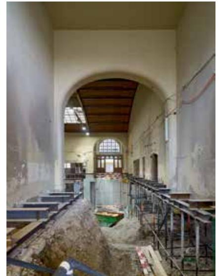
erhalts dem Denkmalrat vorgelegt. Dieser entschied in Abwägung der verschiedenen Schutz- und Nutzungsinteressen, dass die Bodenkonstruktion zwar zum historischen Bestand gehöre, aber im Hinblick auf den rationellen Einbau des Untergeschosses abgebrochen und wiederhergestellt werden könne.
