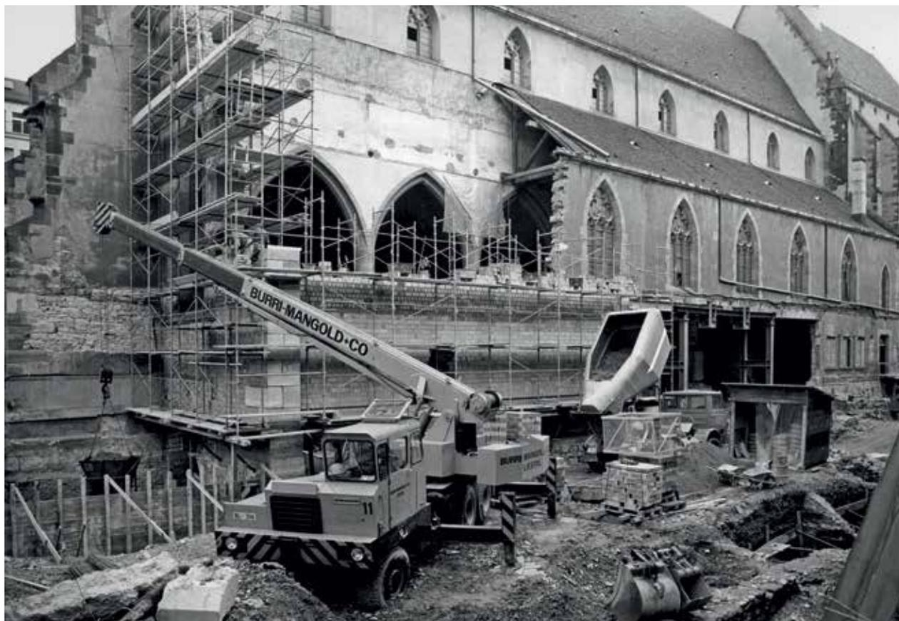
Die Kirche während des Umbaus 1975–1979. Damals wurden Langhaus und Hof unterkellert und das südliche Seitenschiff teilweise wieder verbreitert. Durch Aufmauerung im Norden und Abbruch des Giebelschmucks wurde die Westfassade dem Zustand vor 1844 angeglichen. Foto 1976.
