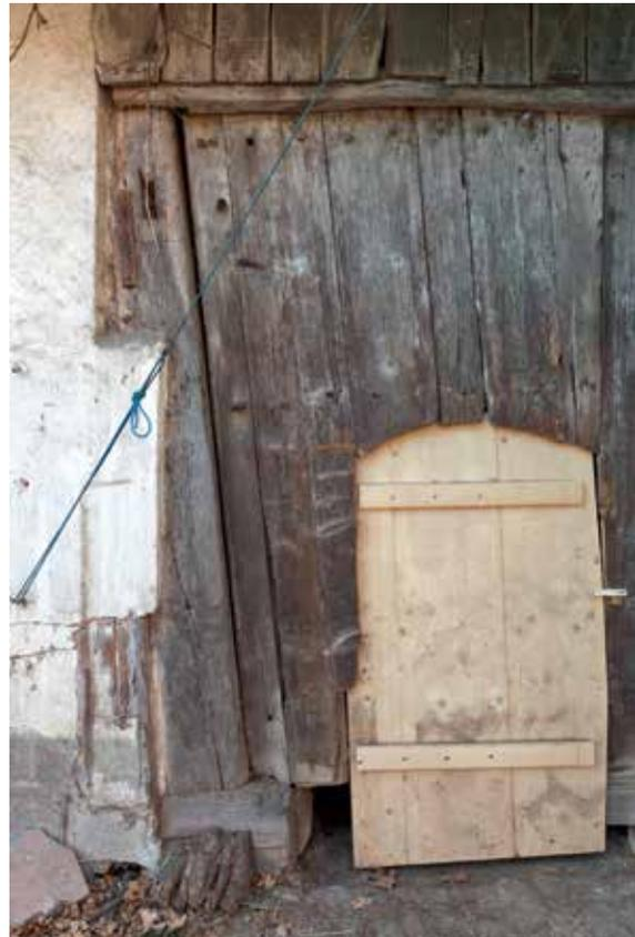
Rechts: Tenntor. Der abgebildete linke Torflügel gehört vermutlich zum ursprünglichen Bestand von 1554, ist aber stark verformt und durch Anpassungen an die Schräglage der Torangelachse verändert. Die Öffnung der erneuerten Schlupftür ist ebenfalls alt. Links ist der Eckpfosten des Wohnteils zu sehen, der unten auf dem erhaltenen Fragment des Schwellenkranzes steht. Die Kranzschwellen überkreuzen sich in der Ecke mit einer Überblattung.
