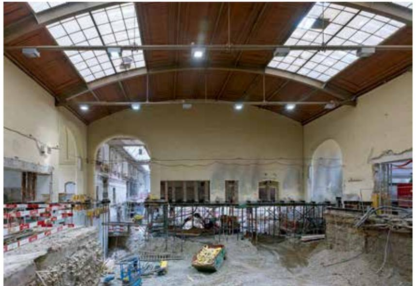
Umbau und Restaurierung des Elsässerbahnhofs. Zustand 2018 während des Einbaus des Untergeschosses. Ehemaliges Restaurant 3. Klasse (oben links); Halle des Elsässerbahnhofs, Durchblick von den Gleisen (oben rechts) und Ansicht gegen Osten (unten).
