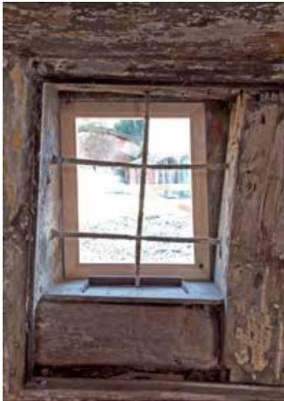
Das Küchenfenster in der östlichen Aussenwand. Während die Fensterlaibung durch die alte, geneigte Ständerkonstruktion gebildet wird und auch die Vergitterung dieser Neigung folgt, ist der äussere Fensterrahmen bei einem Umbau begradigt worden.
