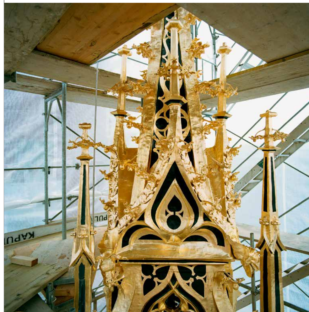
In neuem Glanz. Der obere Teil des 1511 vom Kannengiesser Diebold von Arx gefertigten Dachreiters auf dem gotischen Kernbau des Rathauses. Das als Glockenstuhl dienende Türmchen ist eine mit vergoldeten Bleiblechplatten versehene Konstruktion aus Eichenholz. Für die Neuvergoldung wurden 13 000 Blatt Gold von 23,5 Karat in der Grösse von 8 x 8 cm benötigt.
