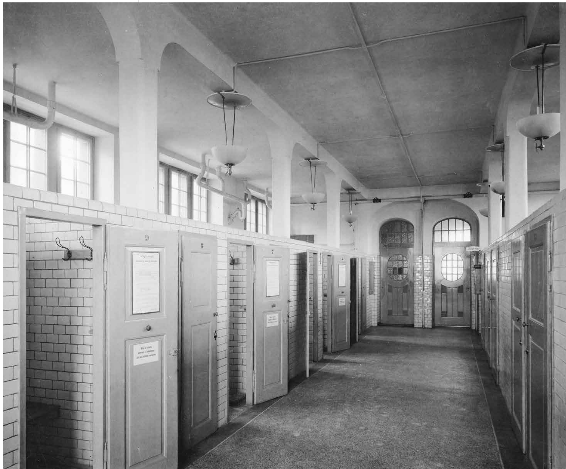
Brausebad. Die historische Aufnahme aus der Erbauungszeit zeigt den Baderaum der Männer im Erdgeschoss, links die Kabinen mit den Badewannen, rechts jene mit den Duschen.
