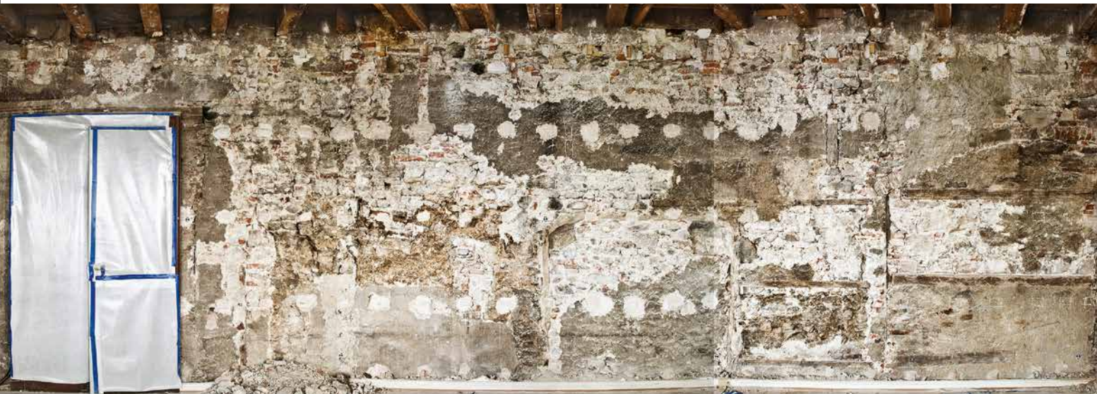
Mittelalterliches Mauerwerk im Rollerhof, Münsterplatz 20. Das 1981 entdeckte Mauerwerk bezeugt ein Gebäude aus dem 12./13. Jahrhundert mit originalem Scharfenfenster und nachträglich eingebrochenem Rundfenster mit Mörtelgewände.
