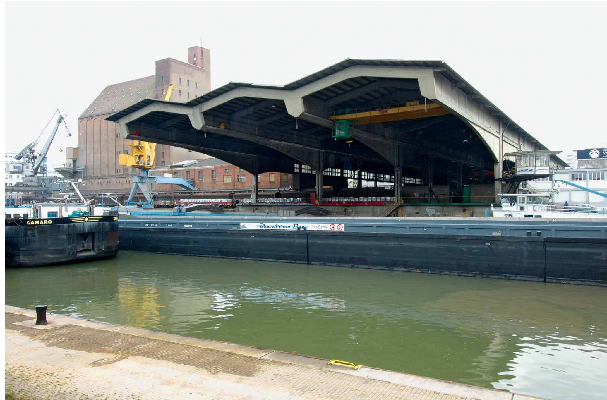
Nachkriegsmoderne: Umschlaghof. Die 1952/53 von den Ingenieuren des Büros Aegerter und Bosshardt zusammen mit den Architekten Bräuning, Leu und Dürig entworfene Lagerhalle am Hafenbecken 1, im Basler Rheinhafen. Sie ist die erste, in der Schweiz im Freivorbau errichtete Tragkonstruktion in vorgespanntem Beton. Im Hintergrund Hans Bernoullis Getreidesilo von 1923.
