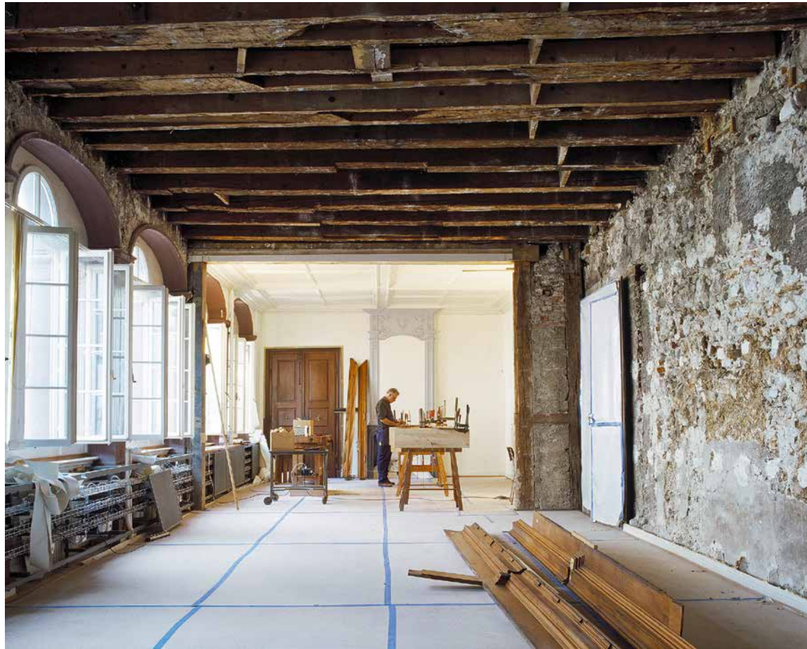
Zurück am angestammten Ort. Der Antiquitäten-schreiner Hans Luchsinger beim Restaurieren der aus dem Historischen Museum zurückgeführten Kassettendecke von 1590. Er arbeitet an einer der drei mit reichem Schnitzwerk geschmückten Kassetten mit den Wappen des Erbauers des Spiesshofs – Balthasar Irmi – und dessen beiden Ehefrauen Anna Wölfflin und Margareth Harscher.
