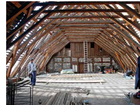
Dachwerk über dem Chor der Klingentalkirche → 46
