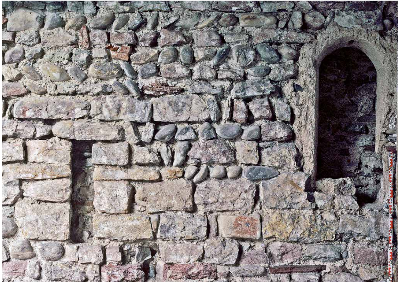
Mittelalterliches Mauerwerk im Rollerhof, Münsterplatz 20. Das 1981 entdeckte Mauerwerk bezeugt ein Gebäude aus dem 12./13. Jahrhundert mit originalem Scharfenfenster und nachträglich eingebrochenem Rundfenster mit Mörtelgewände.
