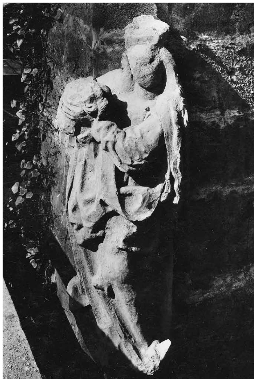
Maria in Wind und Wetter. Die spätgotische Figur der Maria von der Pfalzmauer des Basler Münsters wurde im Sommer 2010 für die Ausstellung «2 Grad. Das Wetter, der Mensch und sein Klima» ausgeliehen. Der Zustand der Skulptur zeigt auf drastische Weise, wie sich Wind und Wetter bei exponierter Lage auf den Stein auswirken. Während die Figur der Maria mit Kind auf einer Fotografie von 1932 noch deutlich erkennbar ist, war sie 1995, zum Zeitpunkt ihrer Entfernung von der Pfalzmauer, zur Unkenntlichkeit entstellt.
